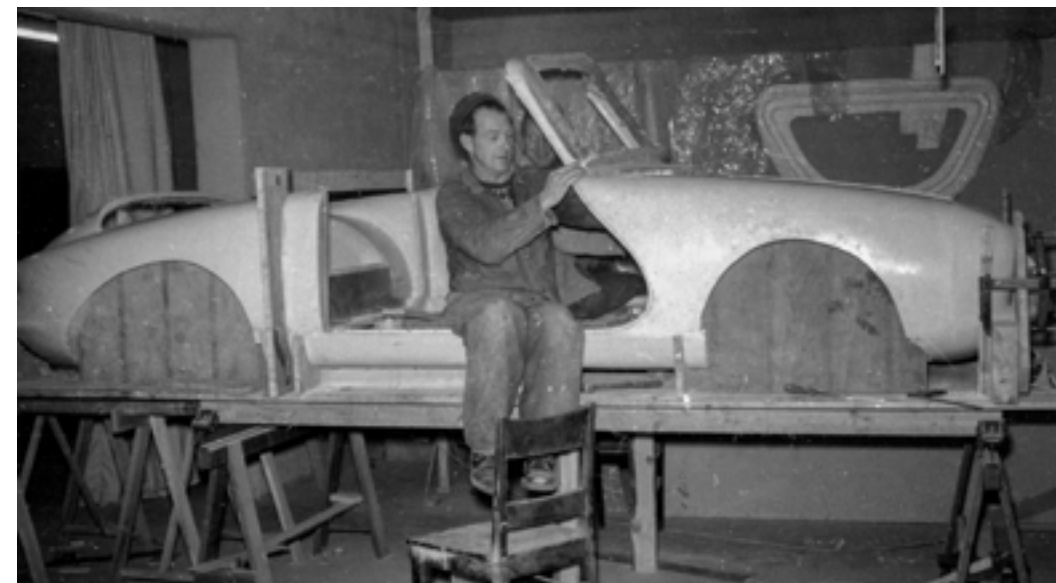
Byggingen av glassfiberkarosseriene i Lunde gikk sakte, for ingen i Lunde hadde erfaring med materialet. (Foto: Per Kohl-Larsen)
