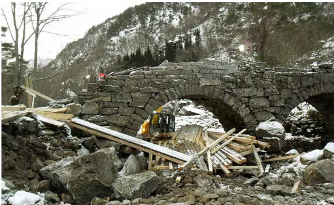
I Grønsdal ved Odda sto en gammel steinbru fra 1840 i fare for å rase sammen etter storflommen i oktober 2014. Nå er den restaurert ved hjelp av en nyutviklet forskalingsmetode. (Foto: Jorunn Monrad)
