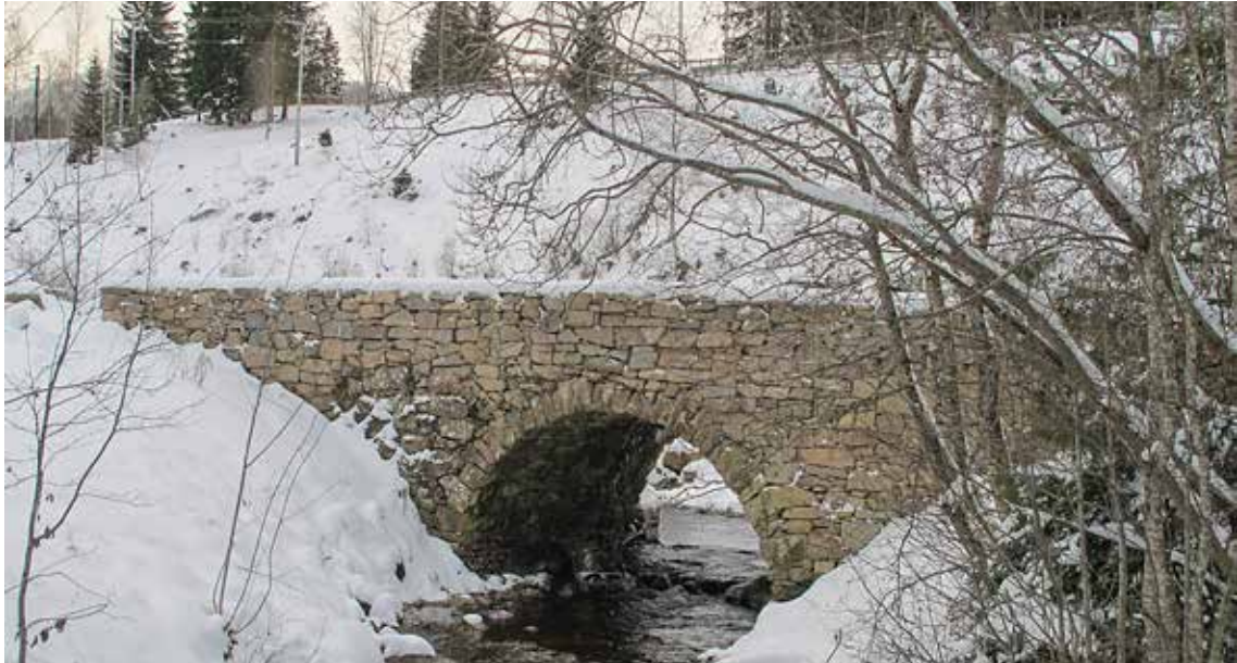
Skjærenbrua over Totenåsen er nå satt i stand i sin tidligere form. Bildet her er fra november 2016, det nederst fra 2012 før restaureringen startet. (Fotos: Ann Kristin Engh)
