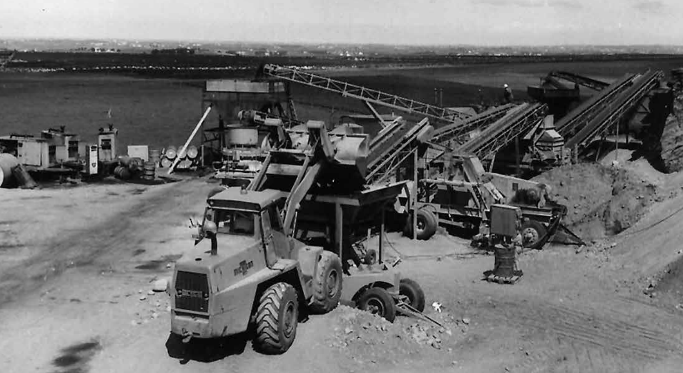
Oljegrusverket er stilt opp på Oppstad, Hå i Rogaland i 1966. Verket er flyttbart og settes opp avhengig av hvor grusen benyttes. All knusing og sortering av masser foregår på stedet. Grus med riktig gruskurve tilsettes olje og aminer og blir mikset til ferdig oljegrus og lagt i silo. Fra denne blir massen veid opp på lastebil og transportert til et brukersted i nærheten. (Foto Arne G. Vasbø)
