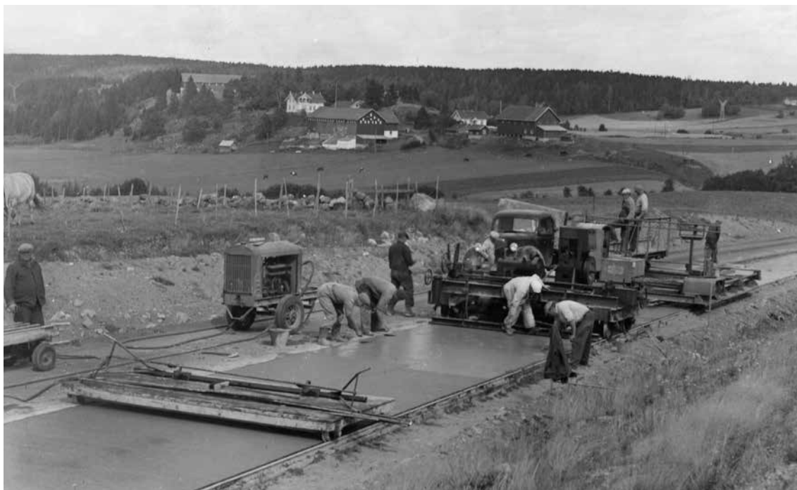
Betongutlegging på E18, i Undrumsdal, tidlig i 1950-årene. På bildet ser vi en moderne tysk utlegger for vegbetong. I årene 1951-1954 ble det lagt adskillig betongdekker på E18 i Vestfold. Dette skjedde i samarbeid mellom Vegvesenet i Vestfold og Veglaboratoriet. Vegkontoret var utførende entreprenør og Veglaboratoriet hadde det faglige opplegg og kontroll.
