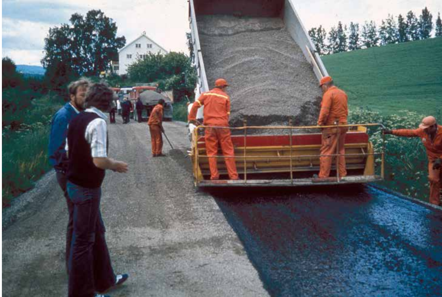
Ottadekke brukt som grov forsegling av krakelert asfalt, her i Oppland i 1966, var en kostnadseffektiv reparasjonsmåte.
