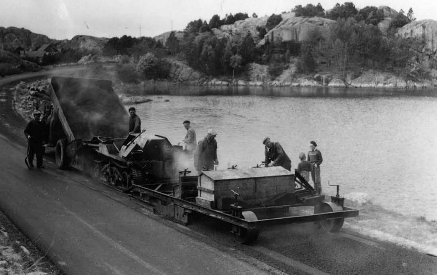
Asfaltlegging på Rv 40 (nå Rv. 44). i 1956 mellom Oгна og Hellvik ved Holmane. Arbeidere ble gjort av Fjellhammer Bruk AS. Dette er trolig forløperen til "Lindhoff asfaltutlegger", en stillbar planskraper som blir trukket av en beltetraktor.
