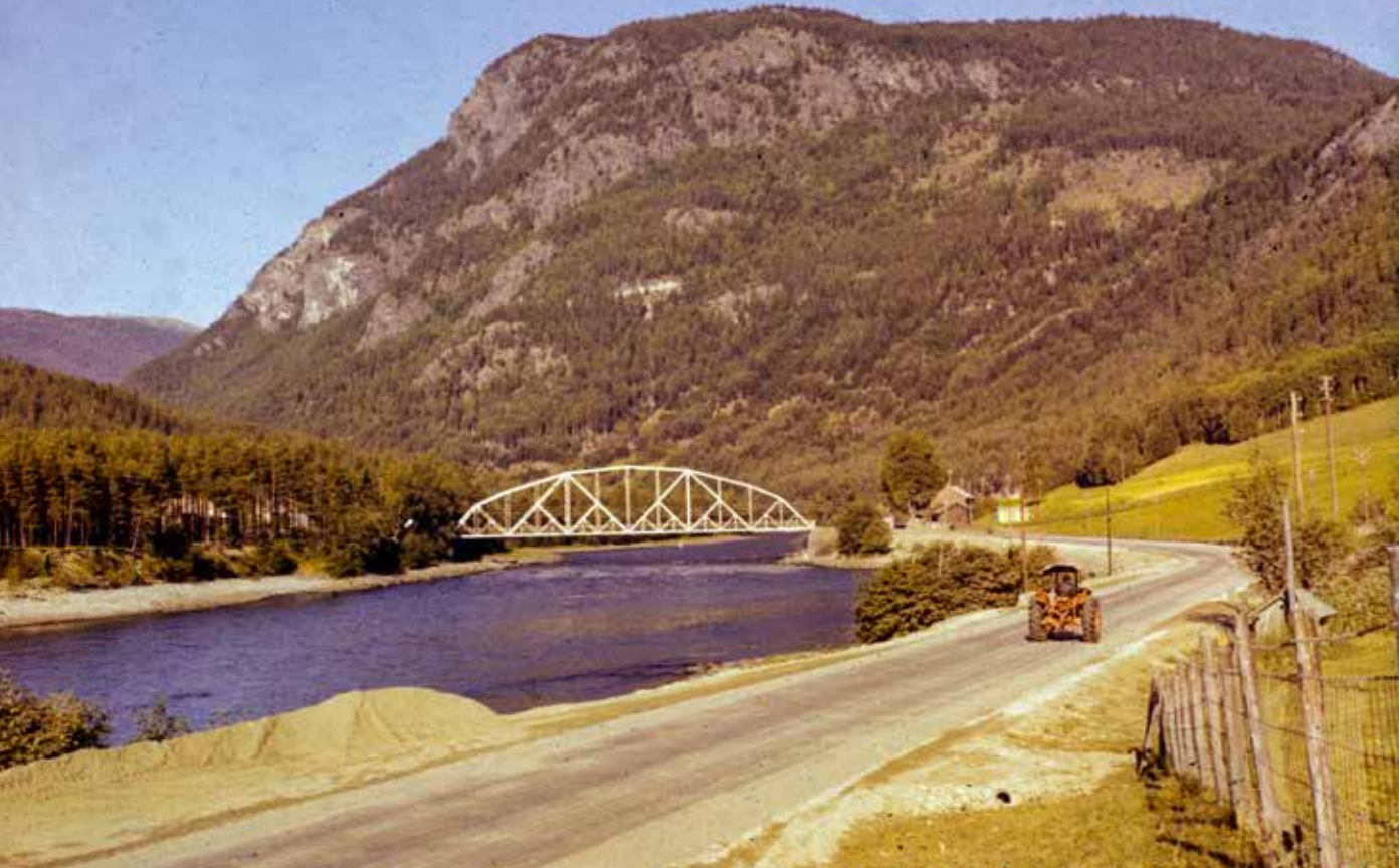
Vegen fra Otta innover dalen var det første storprosjektet som fikk Ottadekke, derav navnet. Åsåren bru, en ekte kattrygg-bru, i bakgrunnen. (Foto Torkild Thurmann-Moe)
