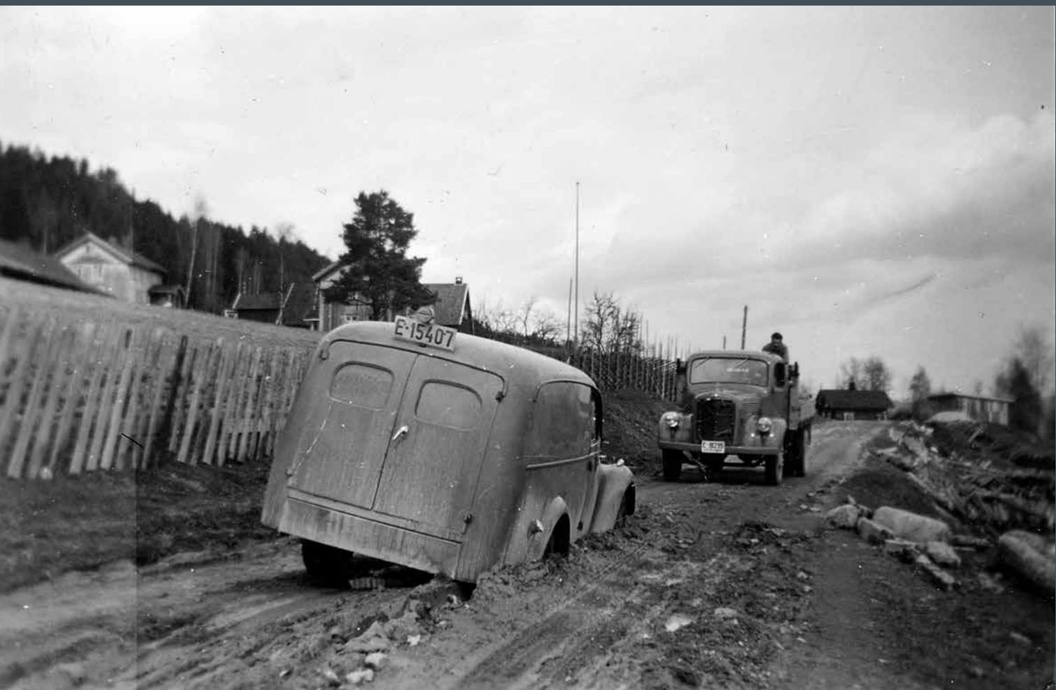
Vårløsningen ved Kvern på Brandbu 20. mai 1952. (Foto: Ingeniør Dahle ved vegkontoret i Oppland.)
