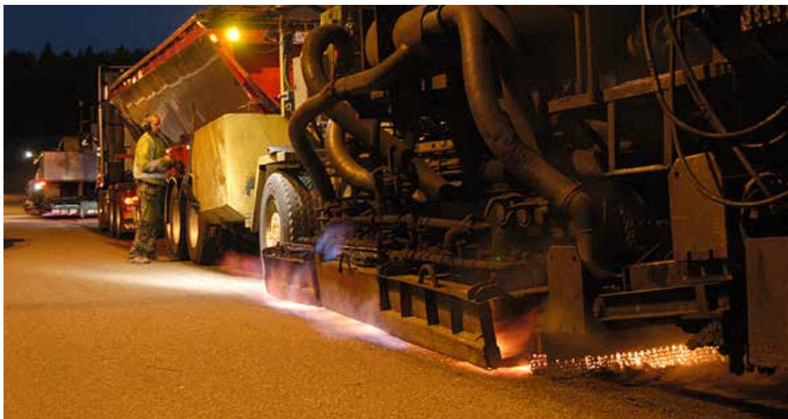
Det gamle dekket varmes med en gassflamme for å gjøre det mykt. (Foto: Håkon Aurlien)
