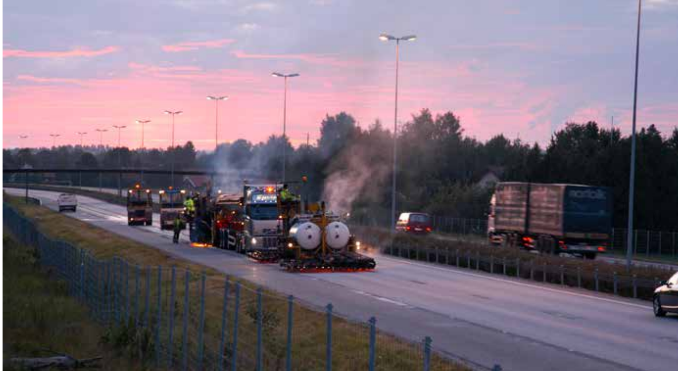
Et dekke kan få forlenget levetid ved sporfylling. NCC hadde dette "toget" i drift på Østlandet i 2009. (Foto: Håkon Aurlien)
