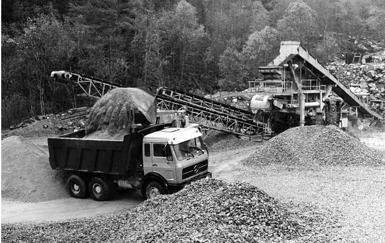
Grusortering til oljegrusproduksjon. (Foto Erling Grønsdal)
