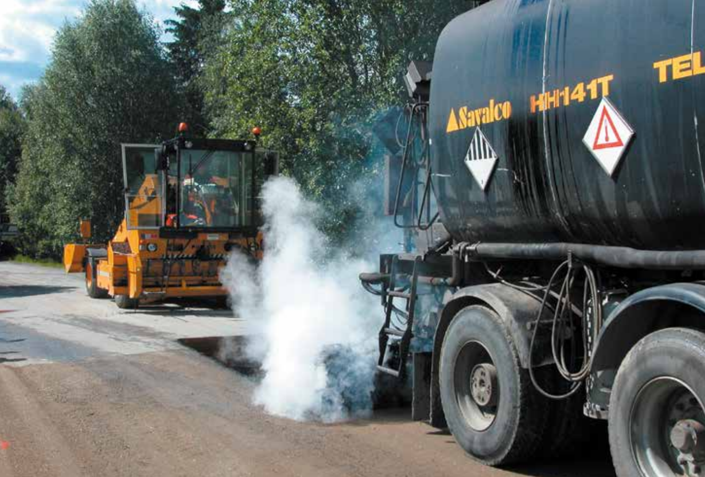
Legging av Ottadekke i nærheten av Hamar i Hedmark.
