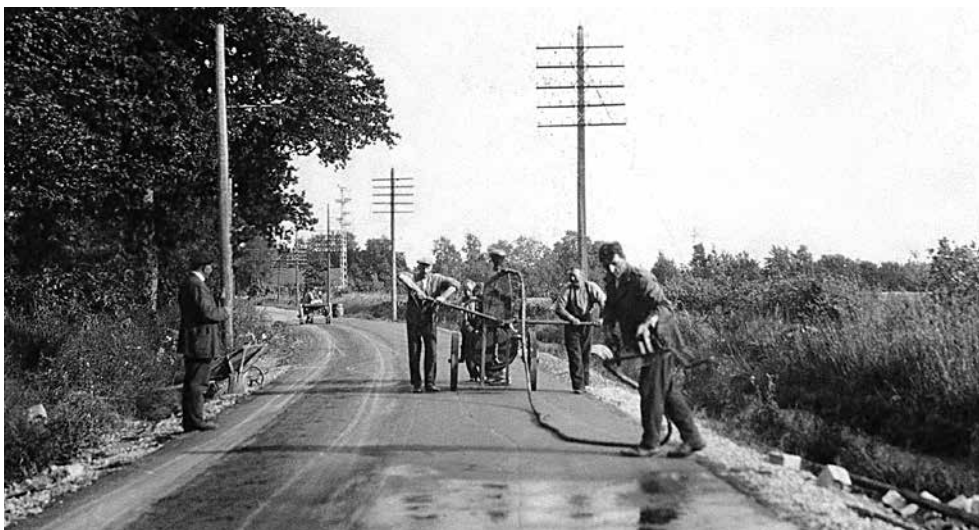
De første forsøkene med oljegrus, legging etter Essenmetoden, skjedde på Ryggevegen, (fra 1928 Rv 1, nå fv 118) i Østfold i 1927.
