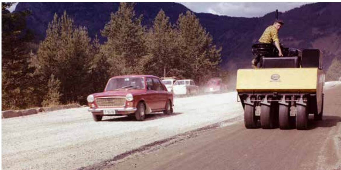
Gummihjulsvalsen i kombinasjon med etterfølgende trafikk ga svært god og effektiv kompaktering av både oljegrus og Ottadekke. (Foto Torkild Thurmann-Moe)
