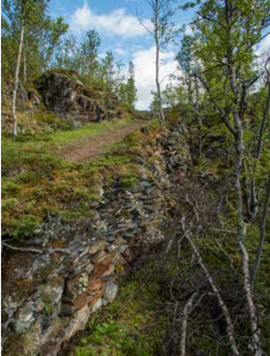
Tørrmurte partier av kongevegen opp Hesthåggåkleiva som viser behov for vegetasjonsrydding og vedlikehold. Hans-Jacob Dahl viser et utrast parti av tørrmuren på bildet til høyre. Foto: Matti Bernitz (bildet til venstre) /Marit Johansson
