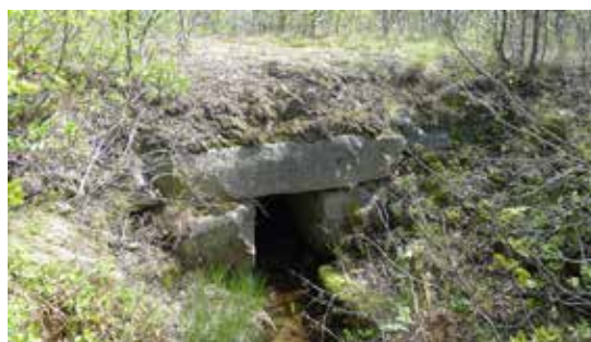
Steinlagt stikkrenne ved en strekning av riksveg 50. Foto: Marit Johansson
