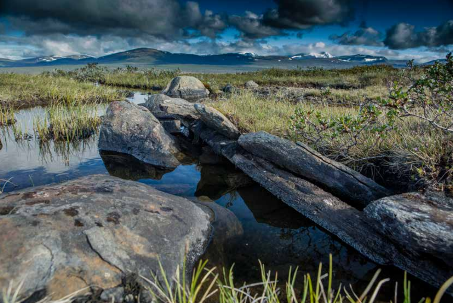
Del av kavlebru med heller mellom Vesle-Hondyrju og Hondyrju som ble datert til slutten av 1700-tallet. Foto: Matti Bernitz
