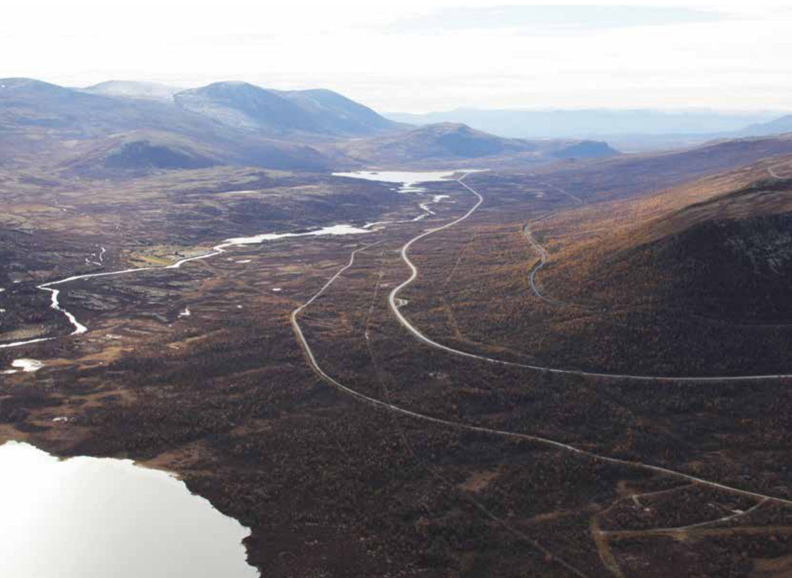
Oversiktsbilde av området mellom Hjerkinn og Avsjøen som viser Dovrefjells veghistorie. Fra høyre mot venstre sees jernbanen, E6 og tidligere riksveg 50 tydelig. Kongevegens trasé sees mellom E6 og riksveg 50. Foto: Kjetil Rolseth
