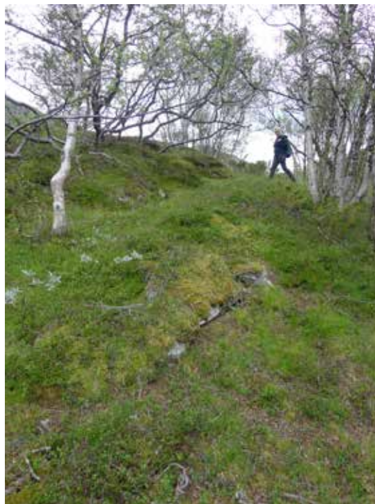
En del av kongevegens eldste trasé som ligger nord for Tingsvaet. Merk oppbyggingen av vegen foran på bildet. Foto: Marit Johansson
