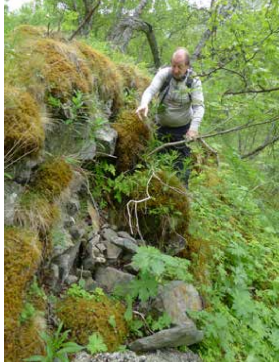
Tørrmurte partier av kongevegen opp Hesthåggåkleiva som viser behov for vegetasjonsrydding og vedlikehold. Hans-Jacob Dahl viser et utrast parti av tørrmuren på bildet til høyre. Foto: Matti Bernitz (bildet til venstre) /Marit Johansson
