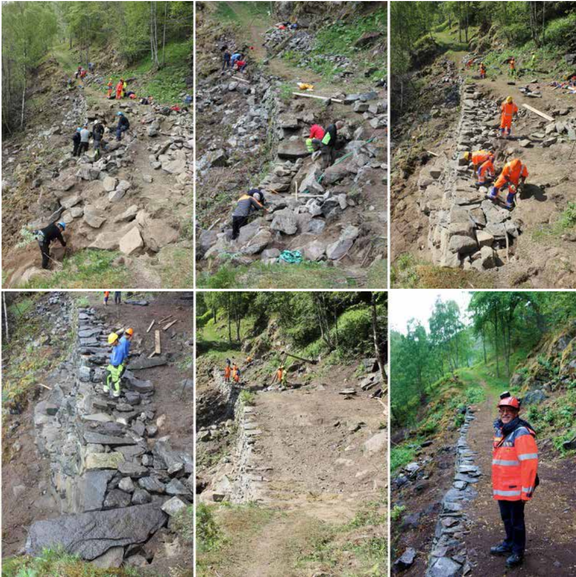
Bildene viser progresjonen gjennom restaureringen av en tørrmur langs Kongevegen over Filefjell. Foto: Jan Adriansen
