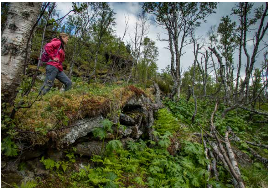
Bilde av tørrmur med tiltaksbehov langs Vårstigen. Foto: Matti Bernitz
