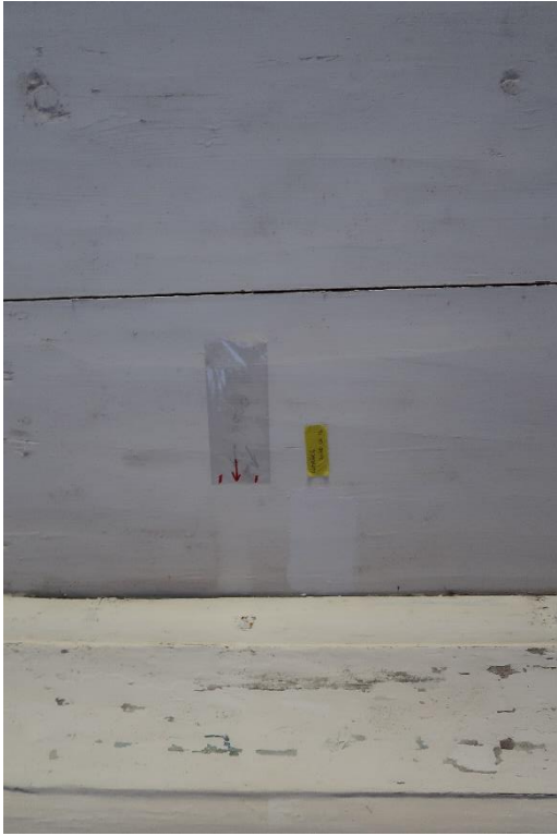
Provytor i taket i salskammaren, med konservatorns märkning
