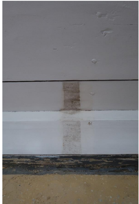
Övre köket efter åtgärder med kvarlämnade referensytor. Limfärgsmålade brädor framför fönstret.
