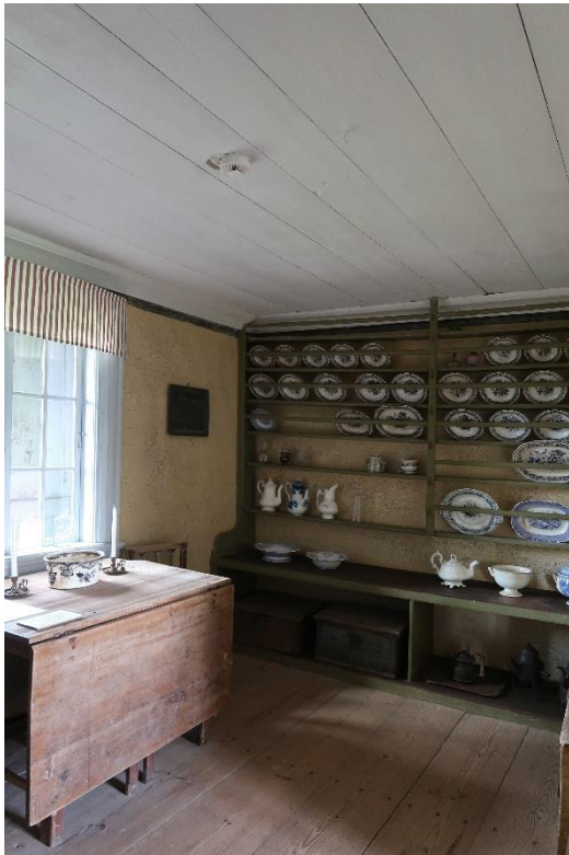
Övre köket efter åtgärder med kvarlämnade referensytor. Limfärgsmålade brädor framför fönstret.
