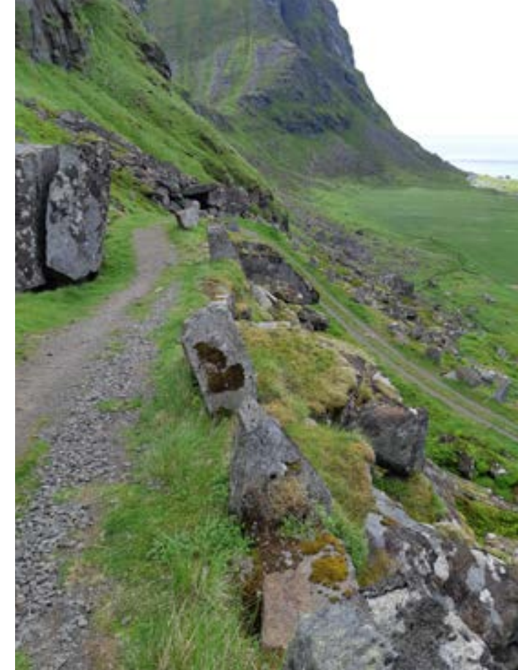
Vegen lagt i krappe svinger, tilpasset terrenget mellom berg og steinblokker. (Foto: Siv Annie Henriksen)
