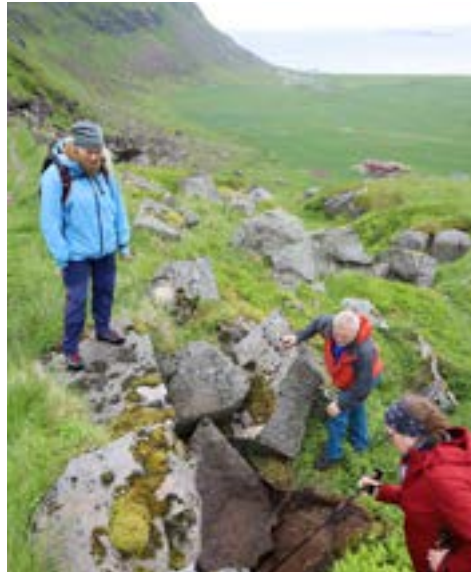
En stikkrenne som er delvis rast sammen må utbedres (Foto: Håkon Aurlien)
