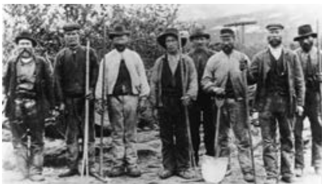
Det finnes ikke foto fra byggingen av vegen over fjellet. Her er et arbeidslag på vegarbeid på en mellomriksveg lenger sør i Nordland, omkring 1900.
