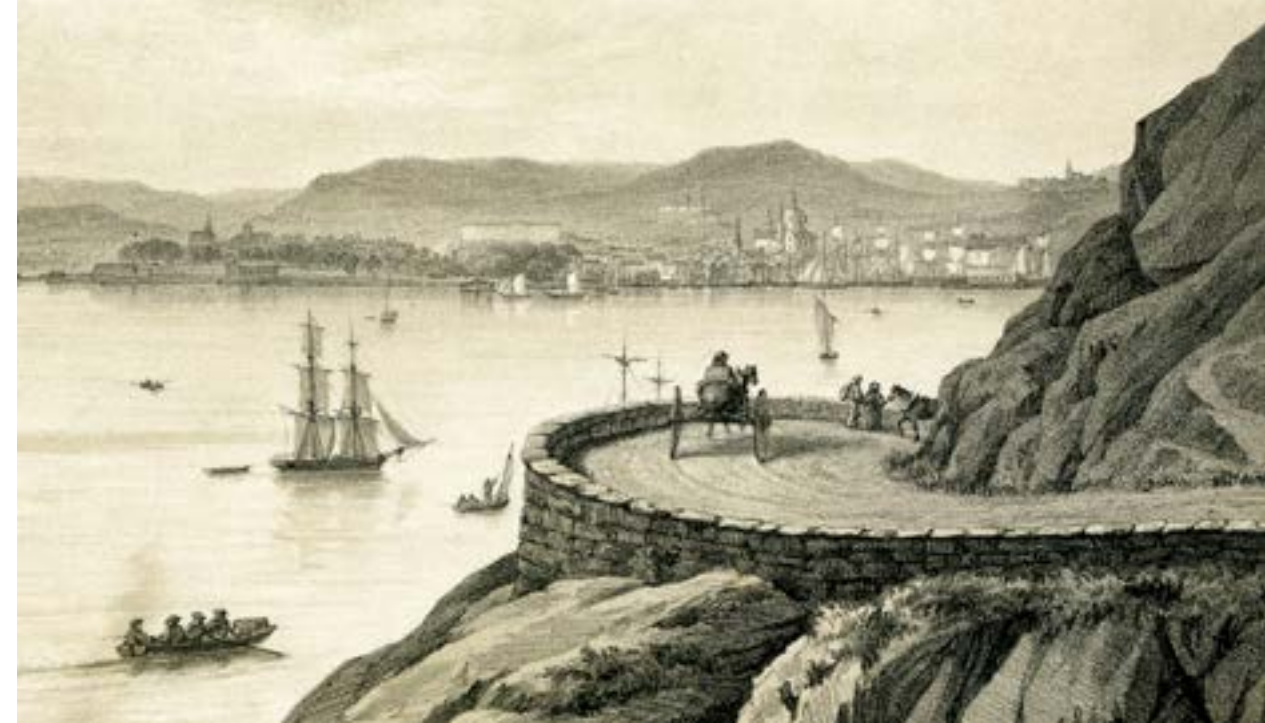
Ljabru-chausséen er innfartsåren til hovedstaden, og stod ferdig i 1849, som et mønstereksempel på den nye type veibygging med slake stigninger som slynget seg i terrenget.
