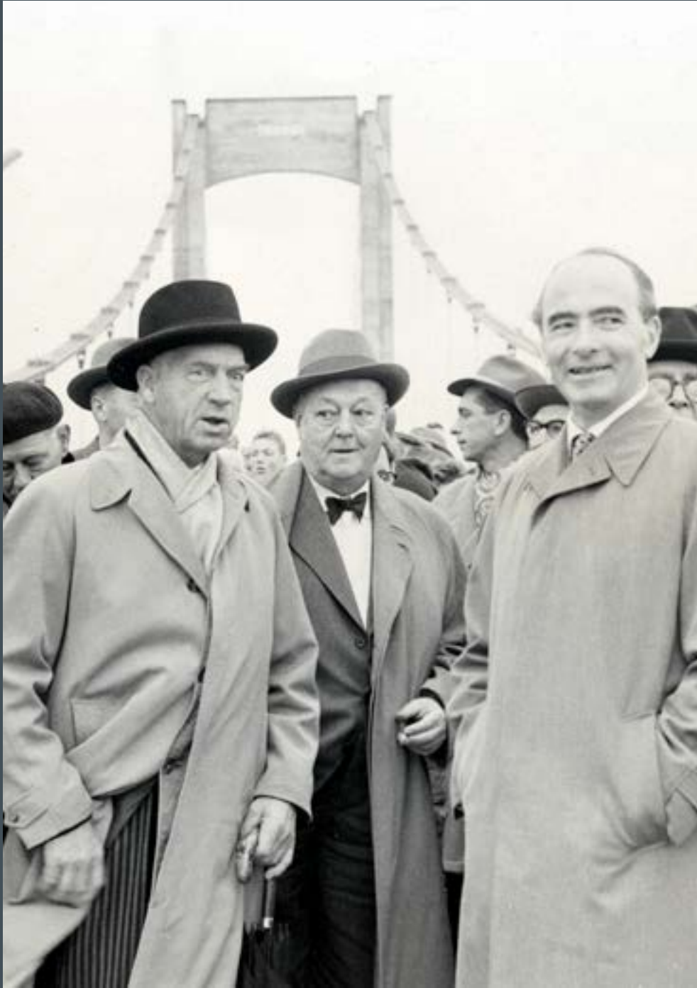
Sterkt engasjement ved åpningen av Tromøybrua ved Arendal 21. oktober 1961. Fra venstre Tromøyordfører Carl Alfredsen, advokat og formann i brukomiteen Chr. Stray, ingeniør Eeg-Henriksen og samferdselsminister Trygve Bratteli.
