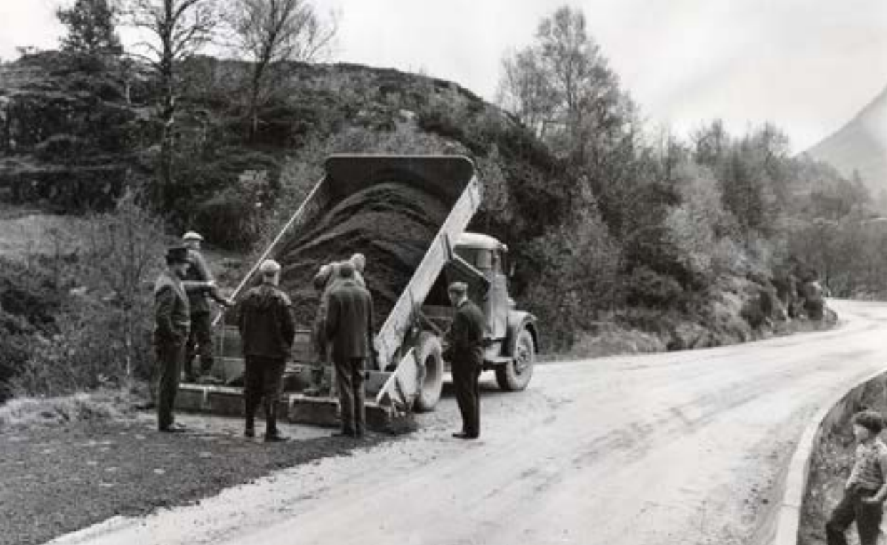
På 1950- og særlig 1960-tallet var «fast dekke» et folkekrav i store deler av landet. Asfaltbransjen vegret seg, de ville legge asfalt i stedet. Dermed ble det startet oljegruslegging i egen regi i Statens vegvesen. Dette bildet er fra første gangs utlegging av oljegrus fra eget verk i Ryfylke i 1964. (Ukjent fotograf)
