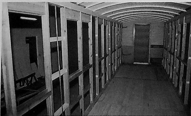
Gulvet og veggene er på plass, og vognkassen er på det nærmeste tvunget sammen. (Alle foto: Trond Dehli)
