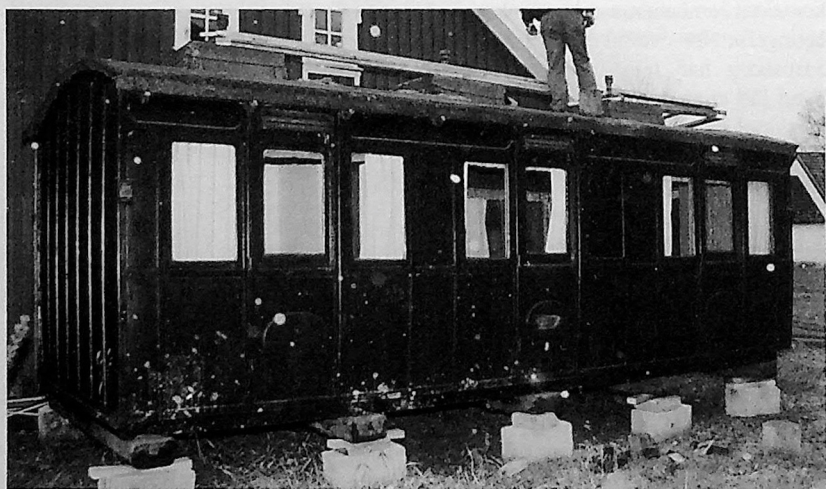
Øverst: "Avkledd" S 199?. Foto tatt ved Varsjø 7/7-1993. (Foto: Roar Stenersen) Nederst: B-karet fra Smaalensbanen, bygget av Skandia i Randers i 1878. (Foto: Borgarsyssel museum 8/11-1993).
