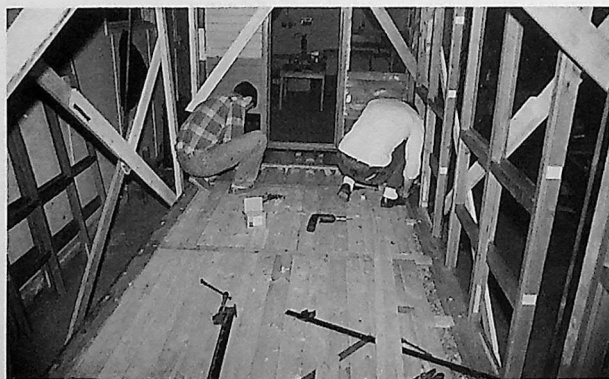
Spikring av innvendig gulv.
