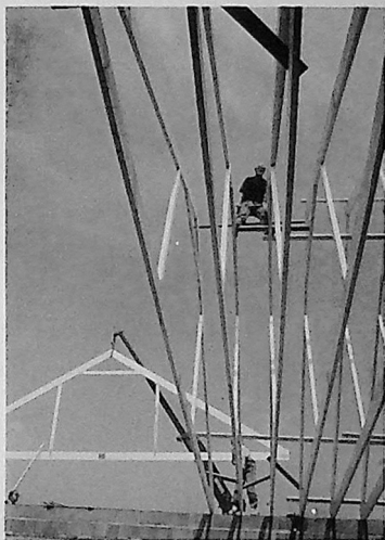
Luftige svev ved montering av takstolene. Snakket noen om "å gå på planken"? (Finn Halling)
