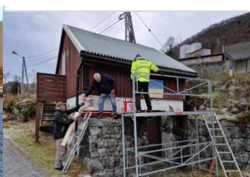
Renovering av trafokiosken
