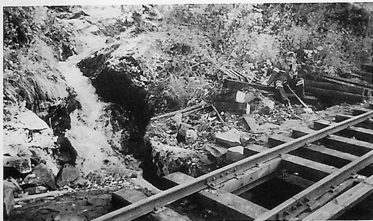
Roel Houtsma tar en pust i bakken under banearbeider ved Småfoss bro sommeren 1999. Broen ble rettet opp samtidig so m det ble foretatt svilleskifting i skinnelengdene på begge sider av broen. Foto. Trond Dehli.
