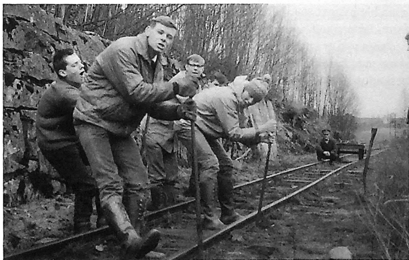
Et godt banevedlikehold er en forutsetning for trygg trafikkavvikling. Her er det aktive i museumsbanens barndom (1965) som bakser spor ved Småfoss under overoppsyn av driftsbestyrer Olaf Wiegels. Foto: Carl Frederik Thorsager.
