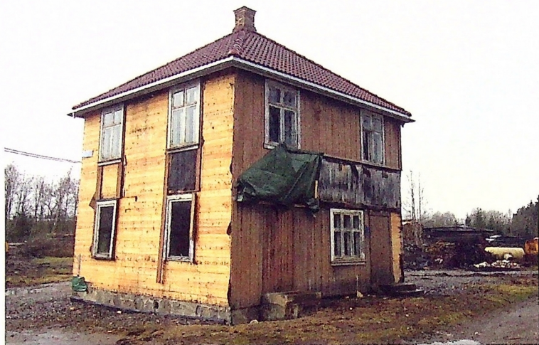
Finstadbru stasjon under restaurering mai 2016. Foto: Dagfinn Lunner
