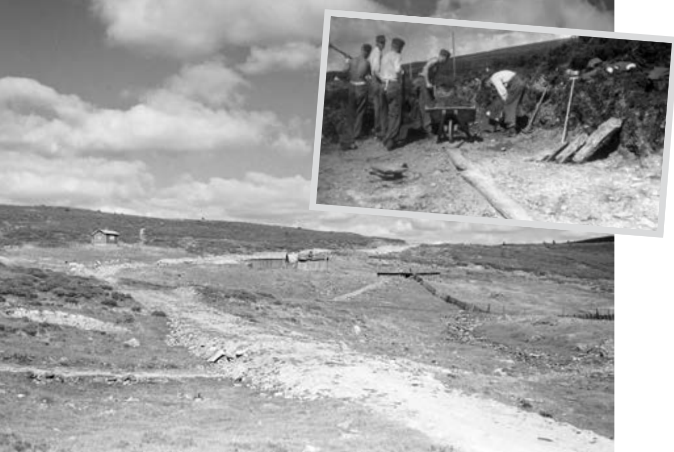
Vegbygginga er i gang i i 1943 med mannskaper frå Arbeidstjenesten med hakke, spade og trillebår. (Foto frå Knut Kvernflaten)
