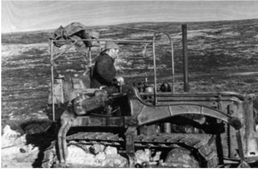
Per A. Løkken kjører bulldoseren. (Foto frå Knut Kvernflaten)
