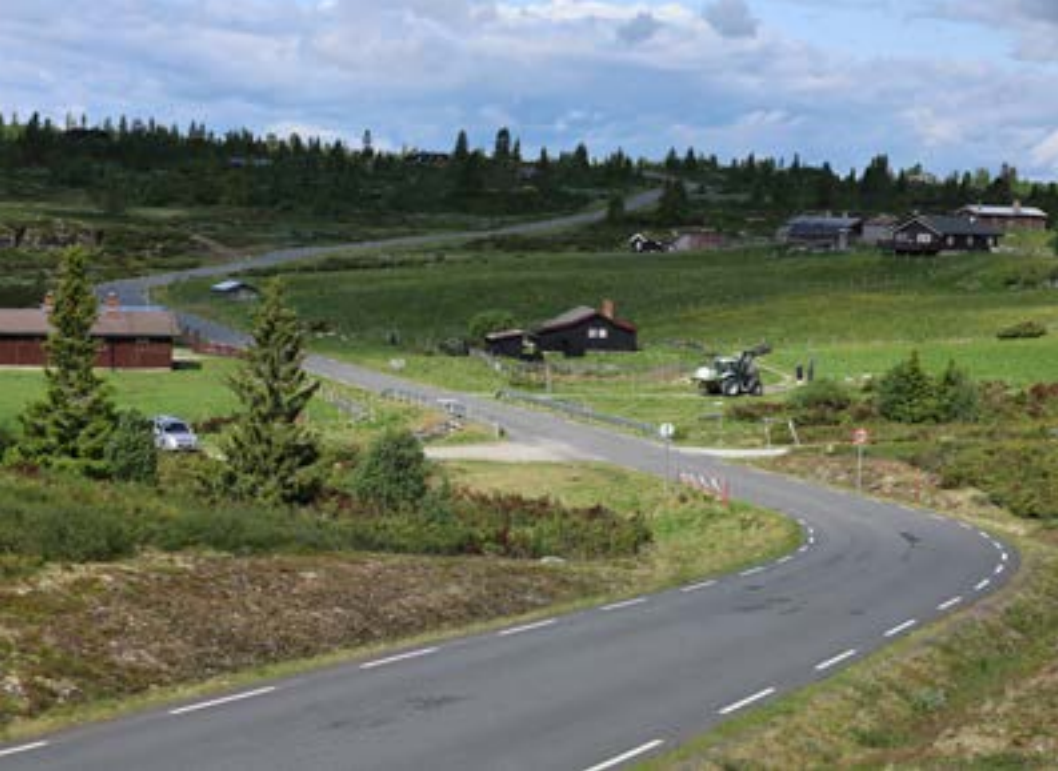
Friisvegen er helårsveg fram til Øksendalen. Videre over fjellet er ho snødekt i vintermånadane. Dei som bygde vegen var påpasslege med å styre unna blautområda. Det forenkla bygginga mye, men vegen vart krokete. (Begge foto: Håkon Aurlien)
