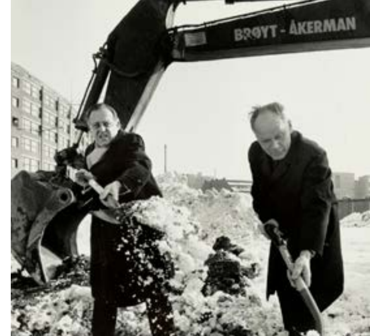
Ordfører i Oslo Albert Nordengen og Eskild Jensen ved Fjellinjens anleggsstart i mars 1987.
