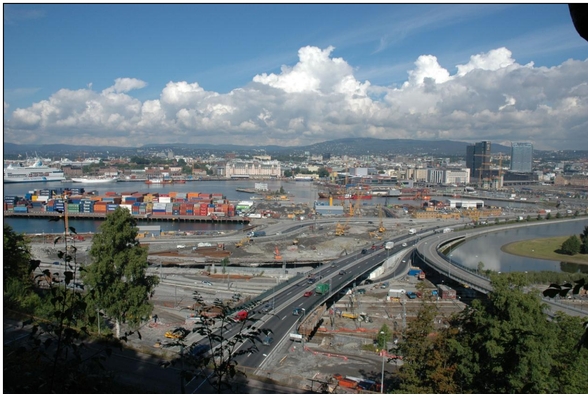
Bjørvika sett fra Ekebergskrenten midt i anleggsfasen, 2007. Foto: Jørgen Johannessen/NSM.
