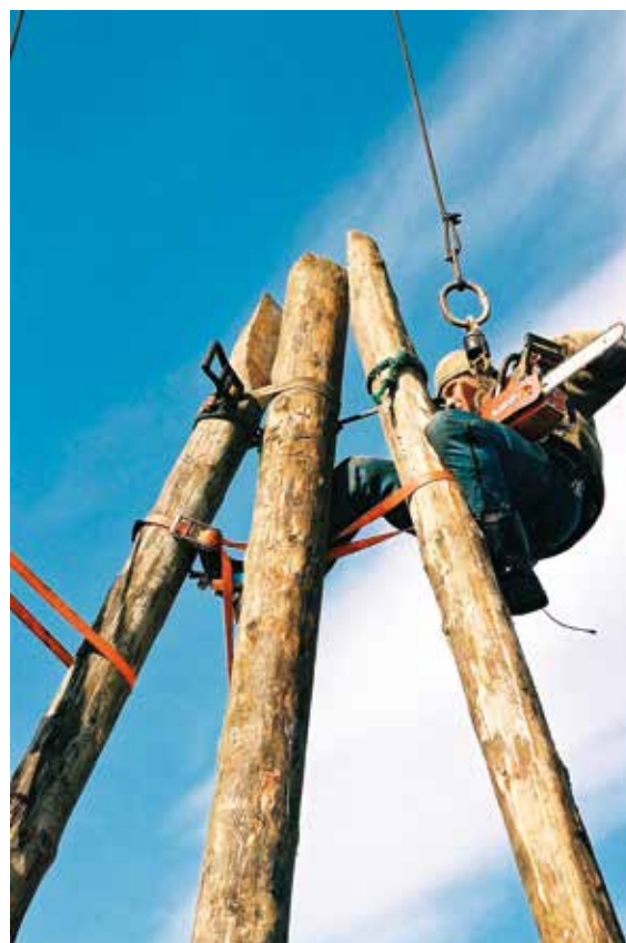
Arbeidet i toppen av galgen var svært anstrengende. Her bør en ikke ha høydeskrekk!
