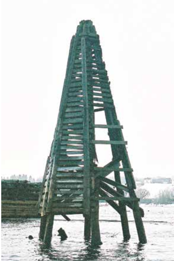
Galge 24A før restaurering.
