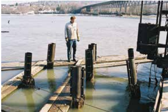
Muffene montert på bunnpålene.
