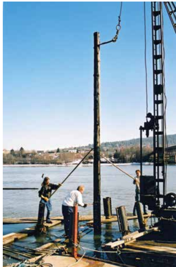
«Kongen» - sentrumspålen, heises på plass og tres ned i muffen.
