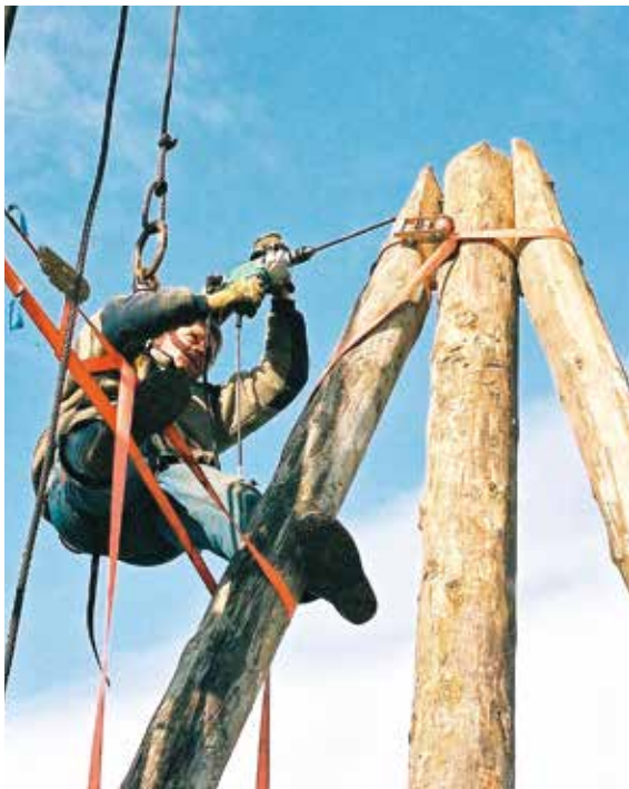
Håndverkeren borer hull gjennom «kongen» og to motstående galgebein.
