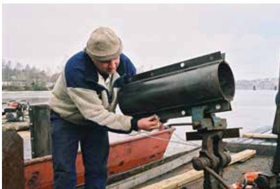
Stålmuffene skrus til med håndkraft.
