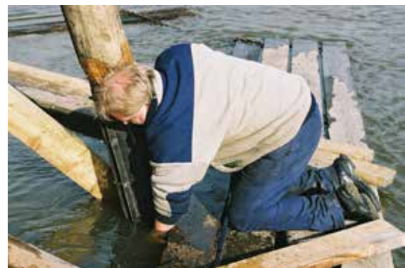
Skråstag monteres. Arbeideren skrur til en gjennomgående bolt under vannets overflate. Iskaldt Glommavann gjør dette til en svært kald opplevelse.
