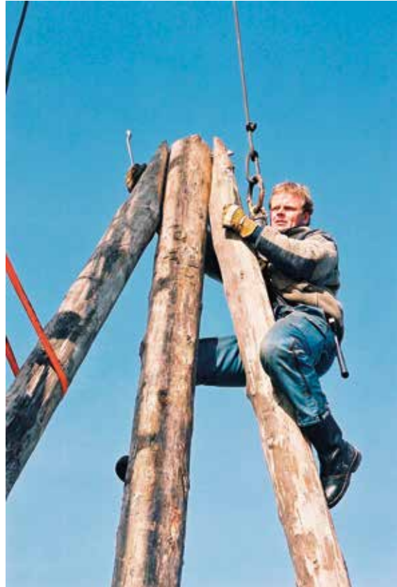
Håndverkeren har stukket en bolt gjennom «kongen» og to motstående galgebein, og låser forbindelsen med to muttere i boltens utstikkende ender.
