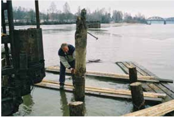
De opprinnelige bunnpålene blir kappet ca. 75 cm over vannflaten.
