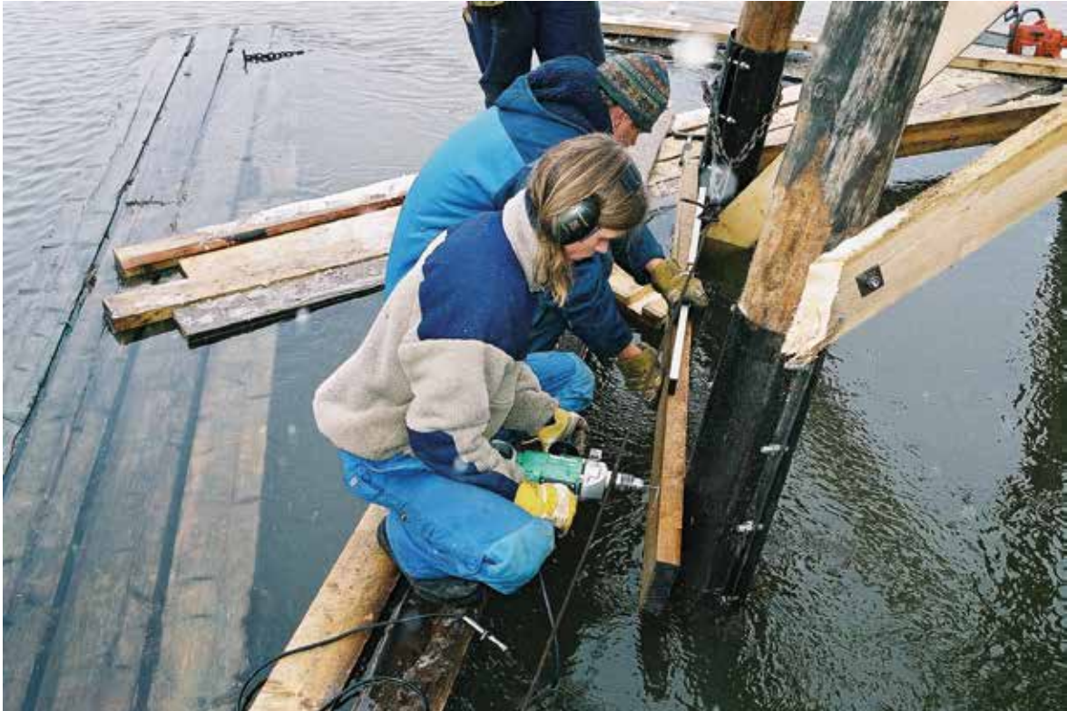
Den nederste horisontale planken monteres. Karene må bore hull i stålmuffen. Vateret brukes hyppig for å sikre korrekt plassering.
