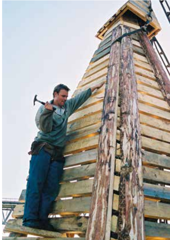
Galgens sidekanter, «halvstokkene» spikres fast.
