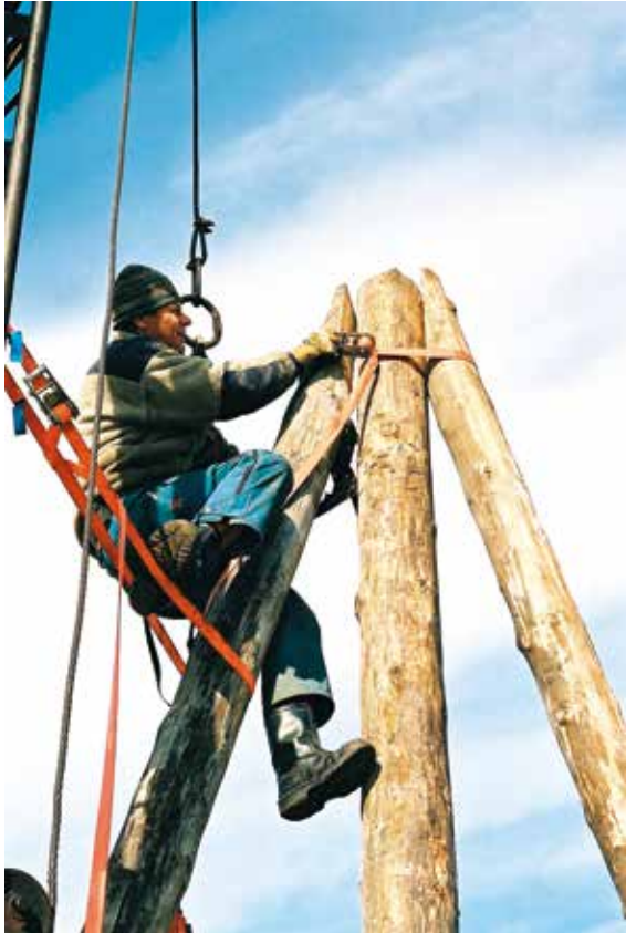
Skråsnitt er skåret i galgebeina som skal ligge inntil «kongen». Ved hjelp av lastsurringer strammes beina inntil hverandre.
