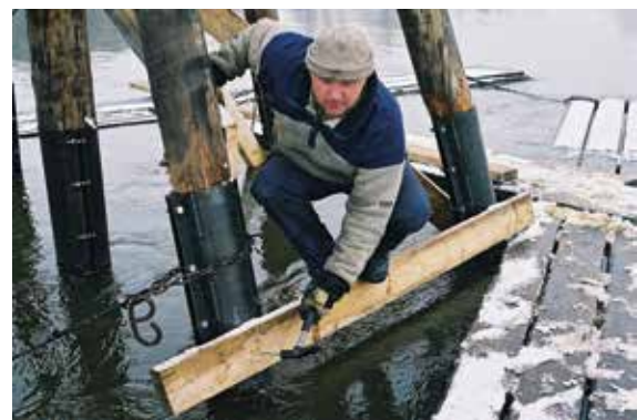
Den nederste horisontale planken monteres. Karene må bore hull i stålmuffen. Vateret brukes hyppig for å sikre korrekt plassering.
