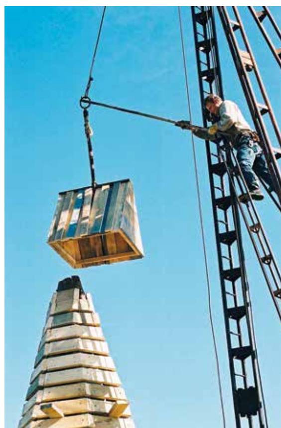
Galgehatten heises på plass ved hjelp av pålebukktårnets vaier.
