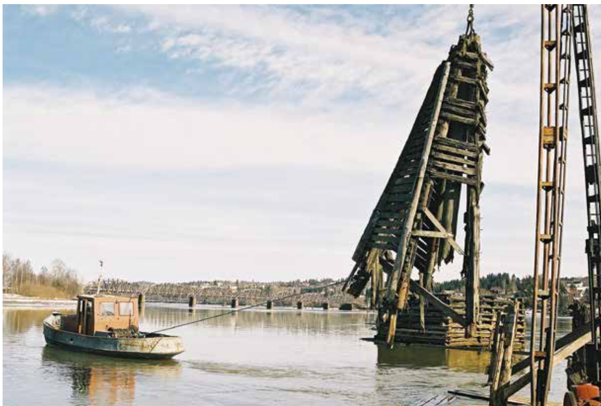
Riving av den gamle galgen. Pålebukktårnet løfter og "Nøkken" trekker.
