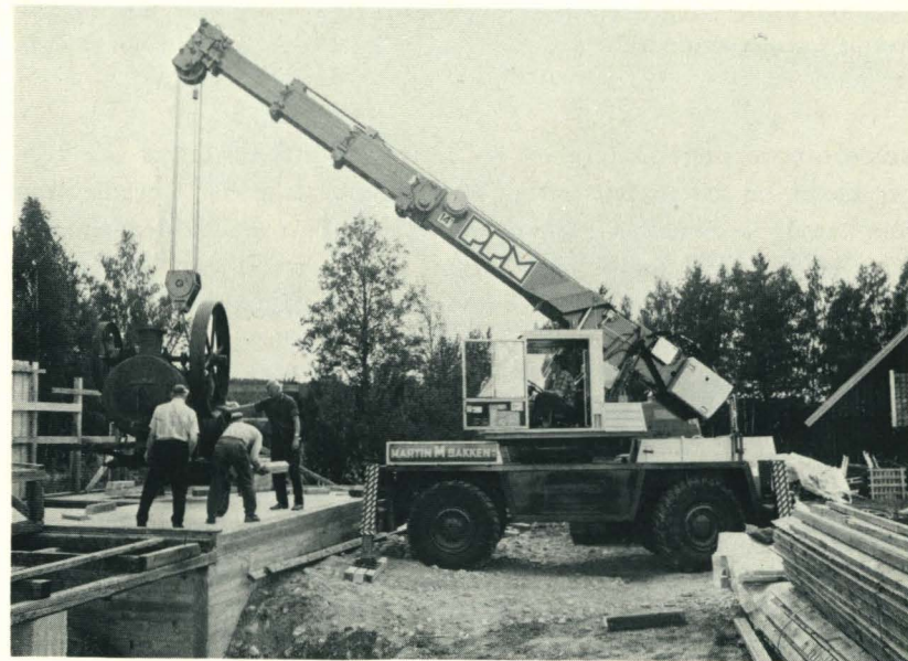
Lokomobilsaga fra Åsnes under oppføring. Lokomobilen løftes på plass. Fra venstre: Trygve Kvesetberg, Arne Sollien og Håkon Sæle. Foto: O. T. L.
