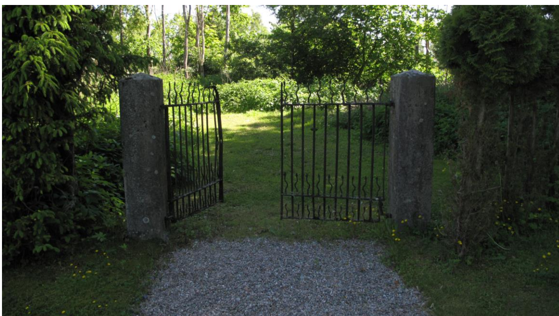
Delvis smidd grind i sydöstra hörnet. Grindstolpar i granit med flackt pyramidformade krön.
