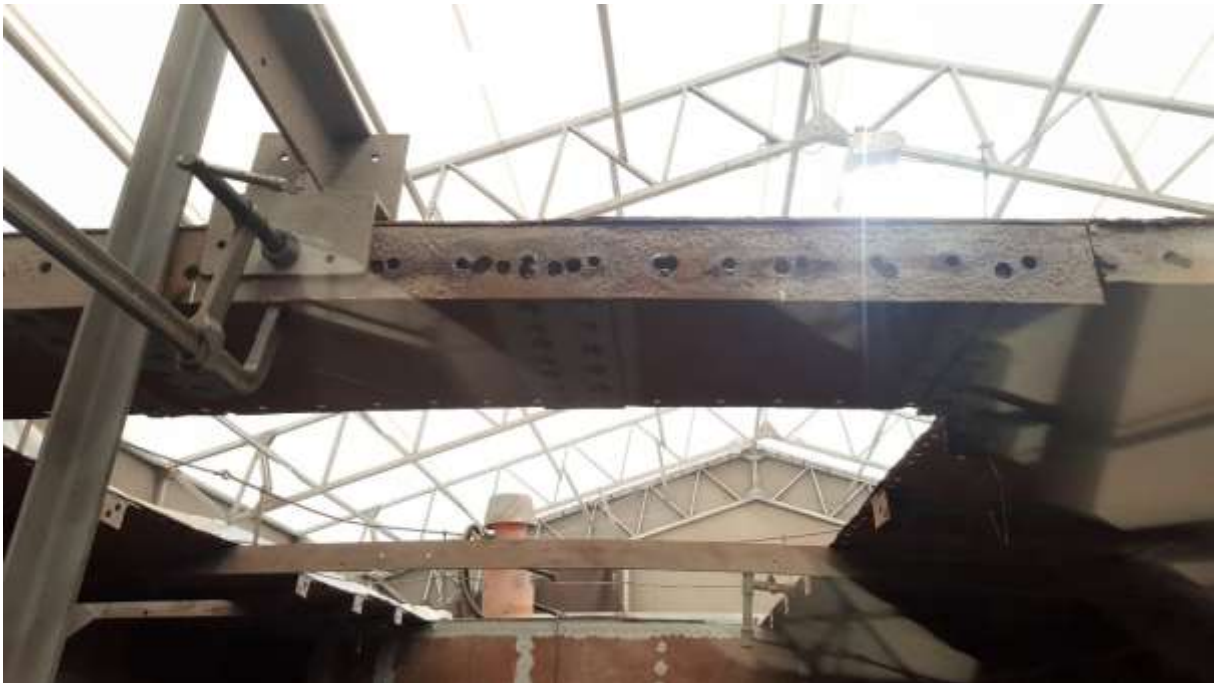
Reparasjon Dekksbjelke spt#10 og feste for maskinskott ferdigstilt
