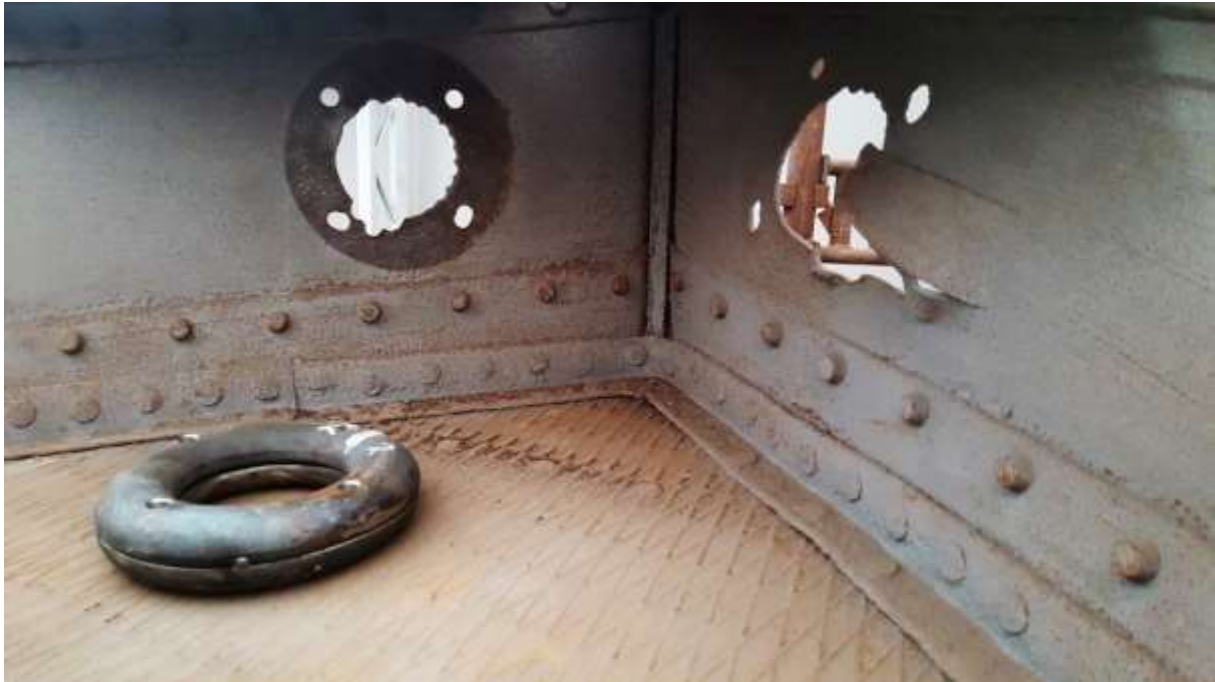
Ferdige ankerklyss, montering gjenstår og rep av plate SB
