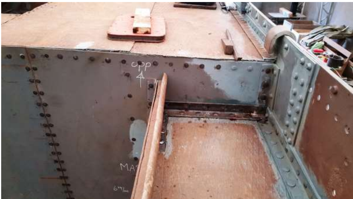
Bindevinkler ferdigstilt i lasteområde BB side samt innfesting til skott v spt #10
