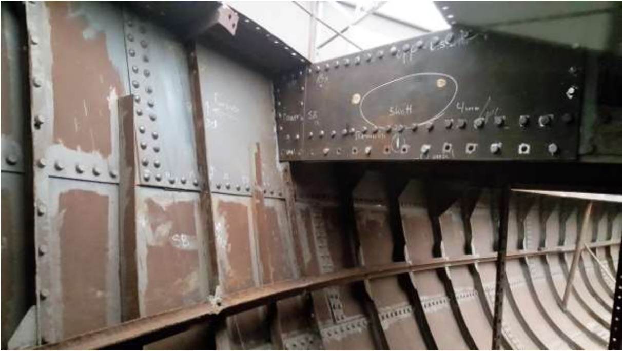
Innvendig svinerygg SB, noe klinking gjenstår
