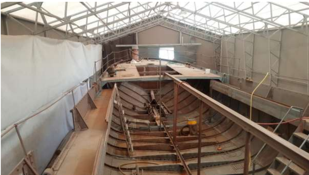
Før montering av nytt skott. Dekksbjelke og bindevinkler på SB og BB lasteområde ferdigstilt
