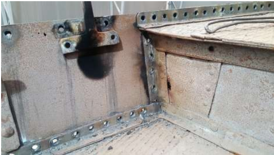
Svineryggen: foto fra SB og BB før demontering av plater.
