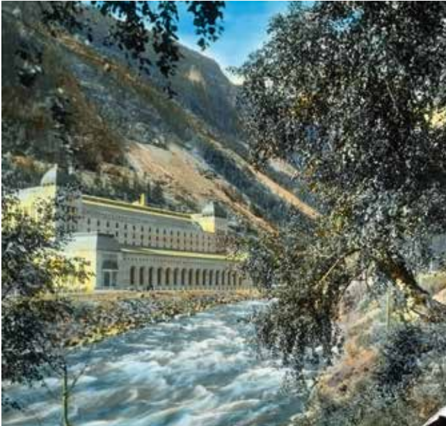
Vannkraftverket Saaheim. Elven Måna renner forbi kraftstasjonen. Rjukan, 1915. Håndkolorert dias.
