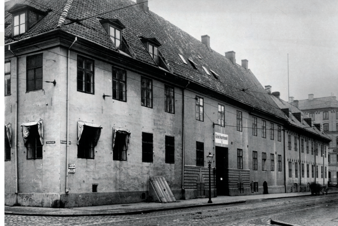
Departementsgården i Dronningens gate 15 besto av to store bygninger. På dette fotografiet fra 1868 ser vi Kirkedepartementets gård på hjørnet av Tollbodgaten. Gården var oppført omkring 1640. Finansdepartementets gård på hjørnet av Prinsens gate var fra 1714. Stortings- og lagtingssalen som var i bruk fra 1814 var plassert i Kirkedepartementets gård, i en fløy i bakgården. Begge saler ble overført til Folkemuseet, henholdsvis i 1914 og 1917. Museet valgte også å ta vare på gården fra 1714 (Finansdepartementet). Den ble gjenreist på museet i 1928, og er i dag Farmasihistorisk museum. Foto: O. Wæring/Norsk Folkemuseum
