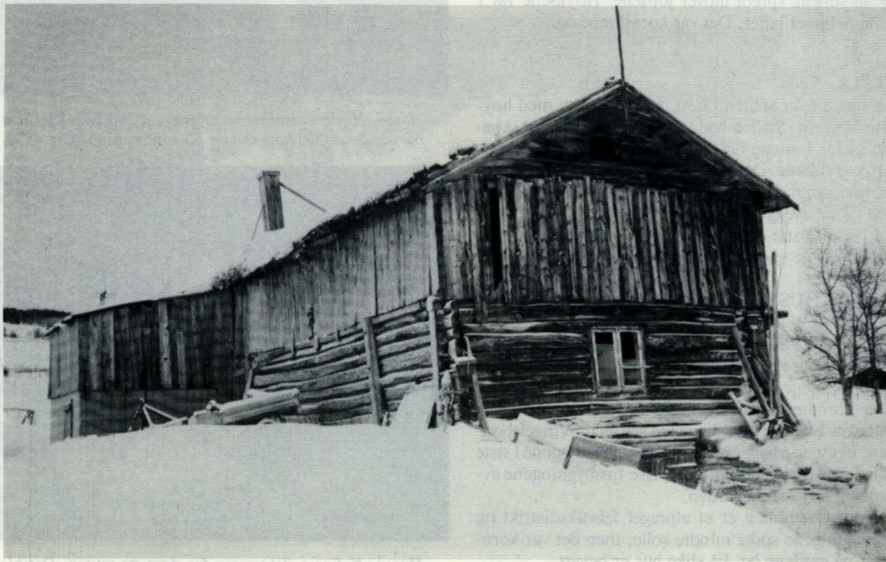
Hagen. «Enhetsbygning» bygd i 1911. Stall i den borteste enden, kufjøs nærmest. Siloen er bygd like etter krigen. Det var da de kom de første innesiloene. Opprinnelig sto saufjøset der siloen står. Det ble flyttet da siloen ble bygd. Sautjøset ble vanligvis bygd i vinkel på den nye enhetsbygningen. Foto: forf. 1990.
