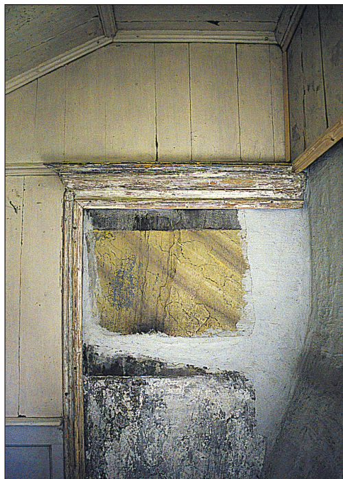
Brannmursmarmorering i et av kammerene, 2. etasje i den eldste hovedbygningen. Midtfeltet, fantasimarmor som illuderer "Giallo di Sienna." Kantene er malt i en fantasimarmor som illuderer "Port d'Or." Ca. 1840. Foto. J.B. 2000.
