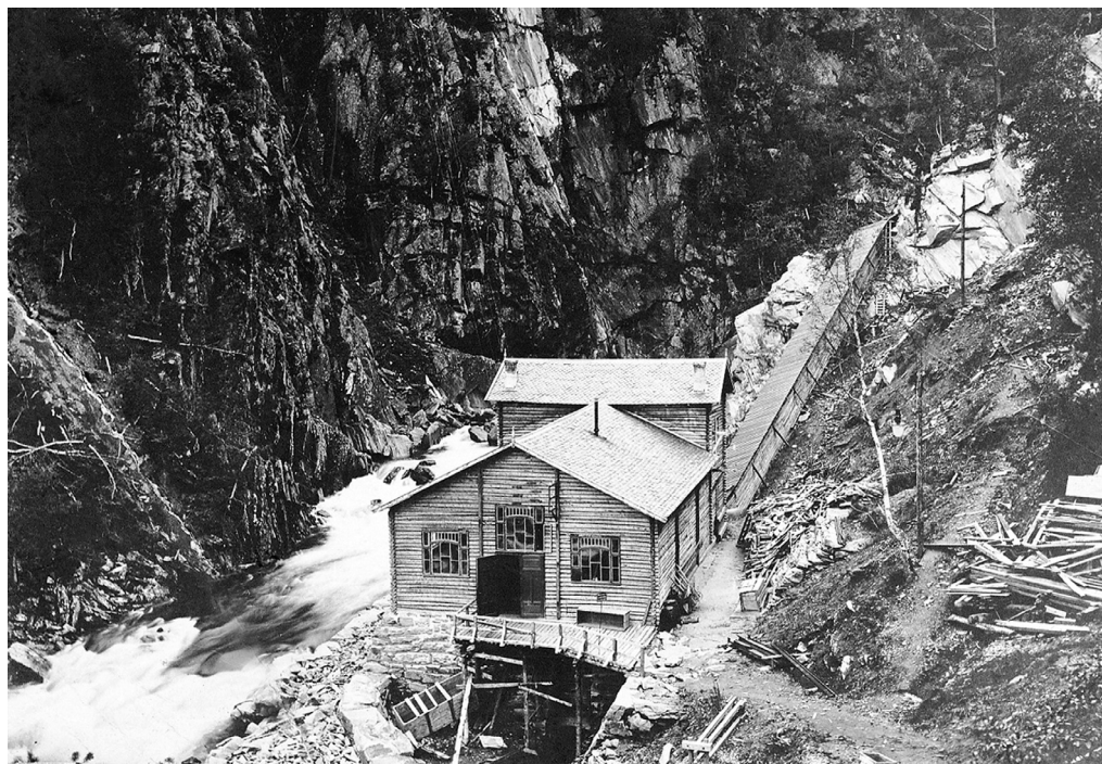
Einunna kraftstasjon ved Einunnfossen, bygd i 1906 for å forsyne Folldal Verks anlegg og maskiner med strøm, samt til lys i Verkets hus og leiligheter. Seinere solgte Folldal Verk også strøm til private i sentrum og nærområdet. MINØ.29243.
