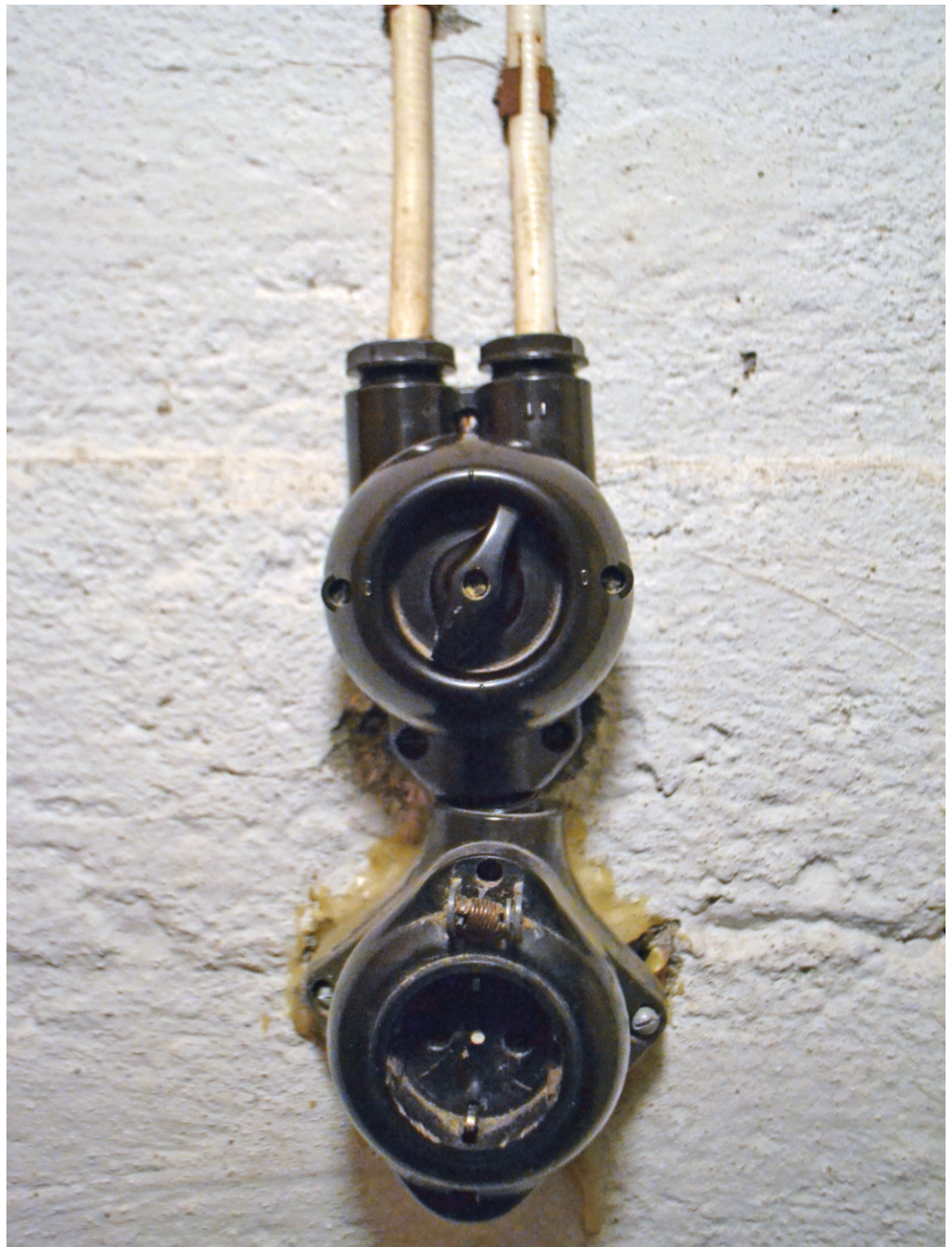
Typisk installasjon fra 1950-åra: bryter og en enkel kontakt. Materialet er hovedsakelig bakelitt. MINØ.126065.
