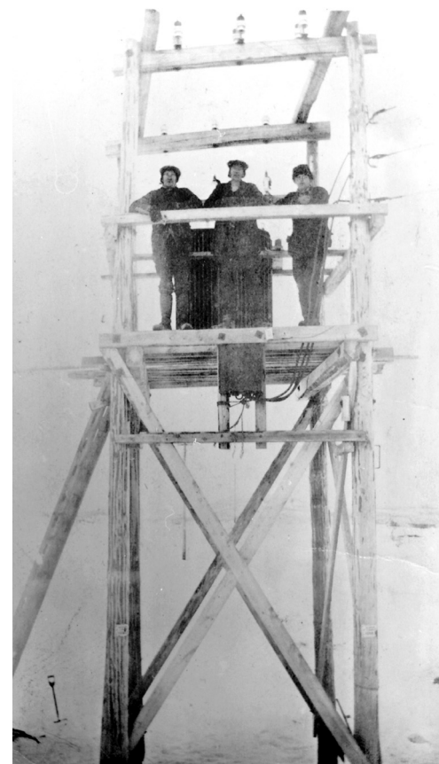
Montering av transformator i Folldal 1954/55. MINØ.42791.
