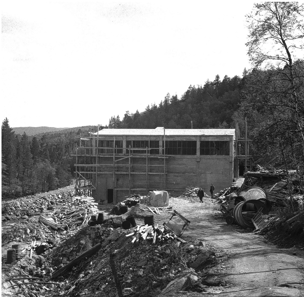
Einunna kraftstasjon under bygging.
