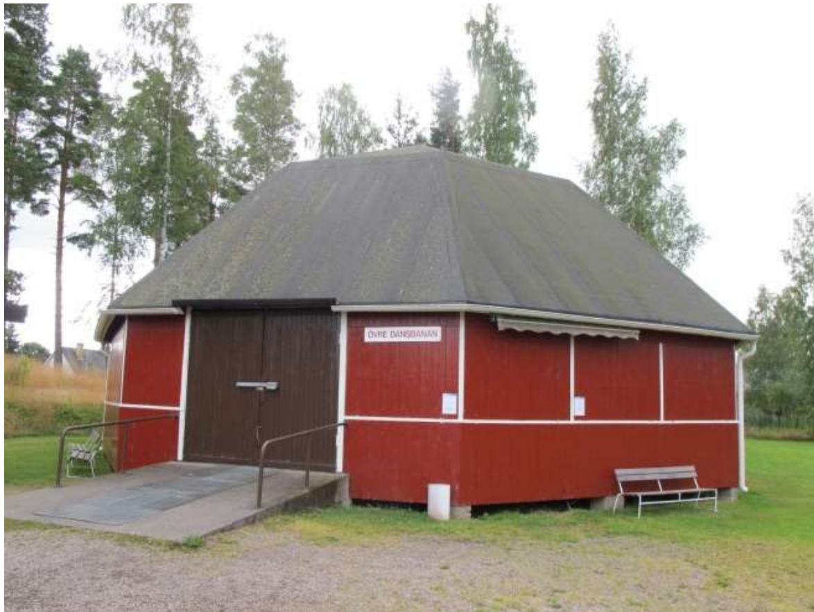
Bild 14: Övre dansbanan efter åtgärd, 4 augusti 2016.
