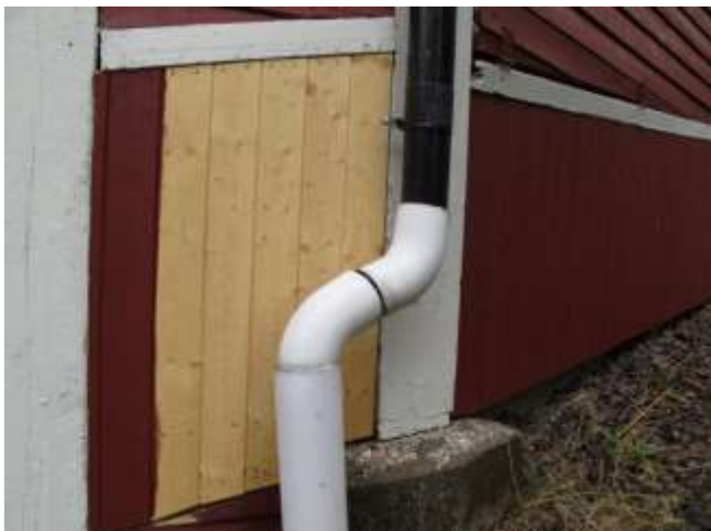
Bild 8: Stora scenen under åtgärd. Till höger om entrén
