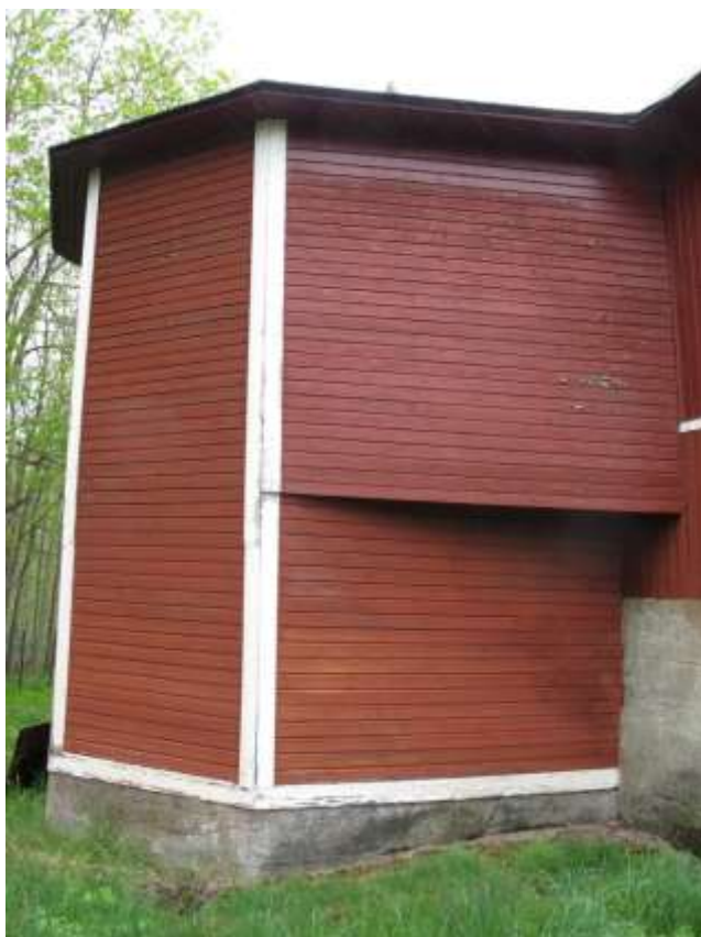
Bild 5: Nedre dansbanan, före åtgärd, 16 maj 2016. Bilden visar en mindre scenutbyggnad på dansbanans bakre del.
