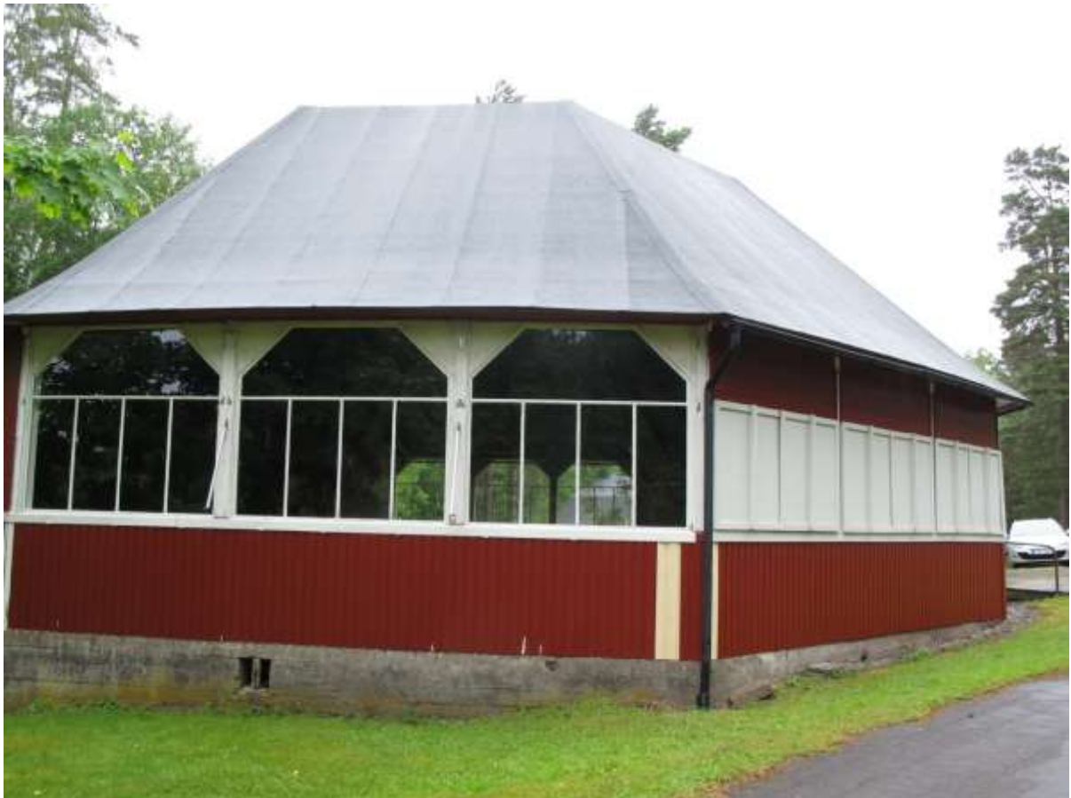
Bild 12: Nedre dansbanan under åtgärd. Rötskadade panelbrädor byttes, 21 juni 2016.
