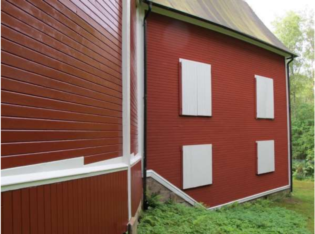
Bild 11: Stora scenens fasader har målats med olika färgtyper. Fasaden till vänster är målad med linoljefärg, medan teaterdelen till höger har målats med slamfärg.
