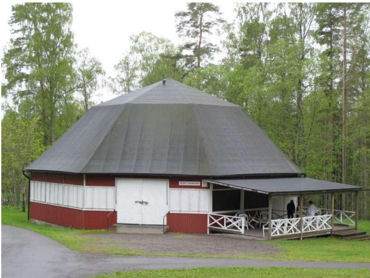
Bild 4: Nedre dansbanan före åtgärd, 16 maj 2016.
