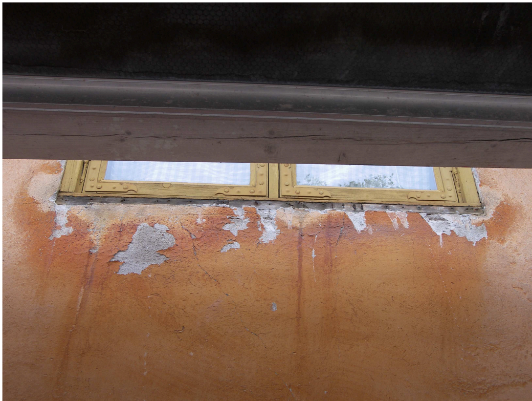
Skador under fönster mot Hantverksbacken. Foto Karin Blent
