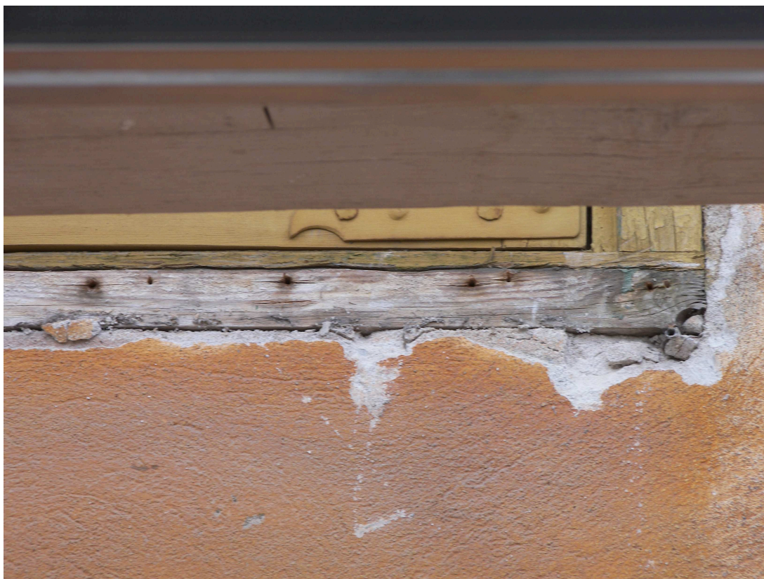
Skador under fönster mot Hantverksbacken. Foto Karin Blent
