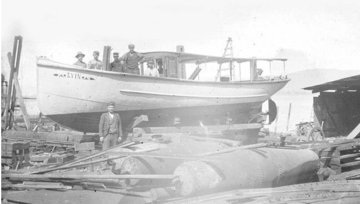
MB Tyin på beddingen ved AS Drammen Jernstøberi, 1906.
