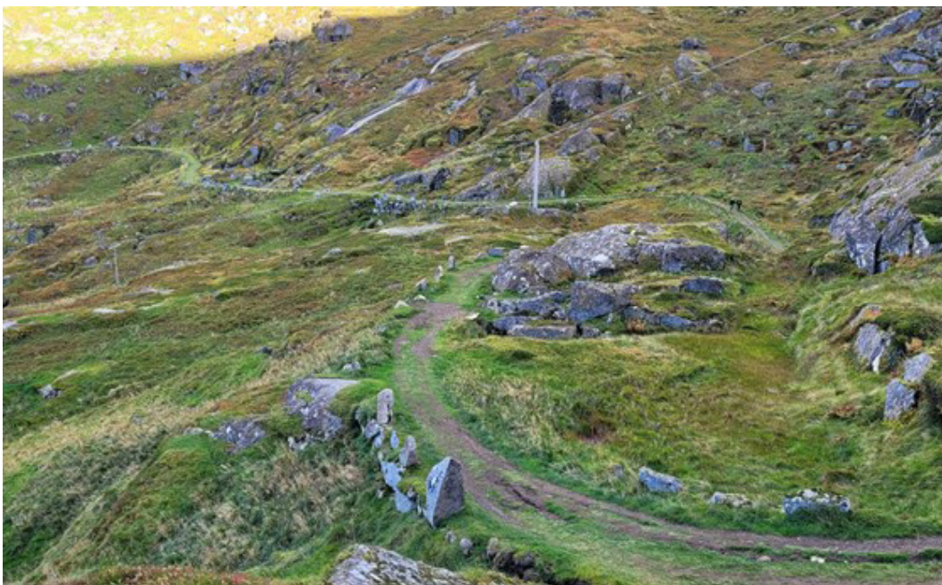
Den gamle ferdavegen mellom Uttakleiv og Haukland i Lofoten. Arbeidet med å sette vegeen i stand startet i 2023. (Foto: Ann Kristin Engh)
