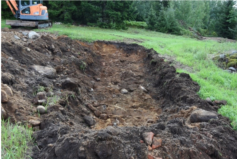
Figur 7. Schakt 3 från norr.
