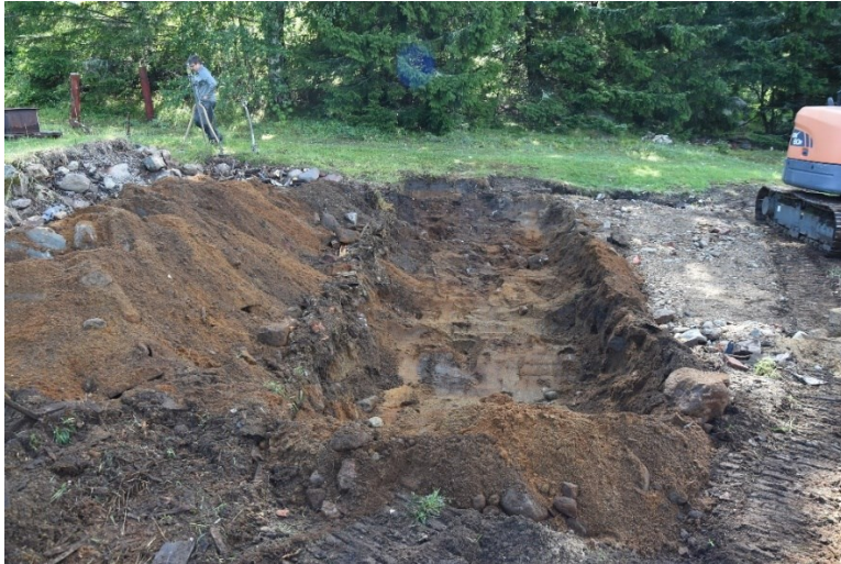
Figur 5. Schakt 1 från norr.
