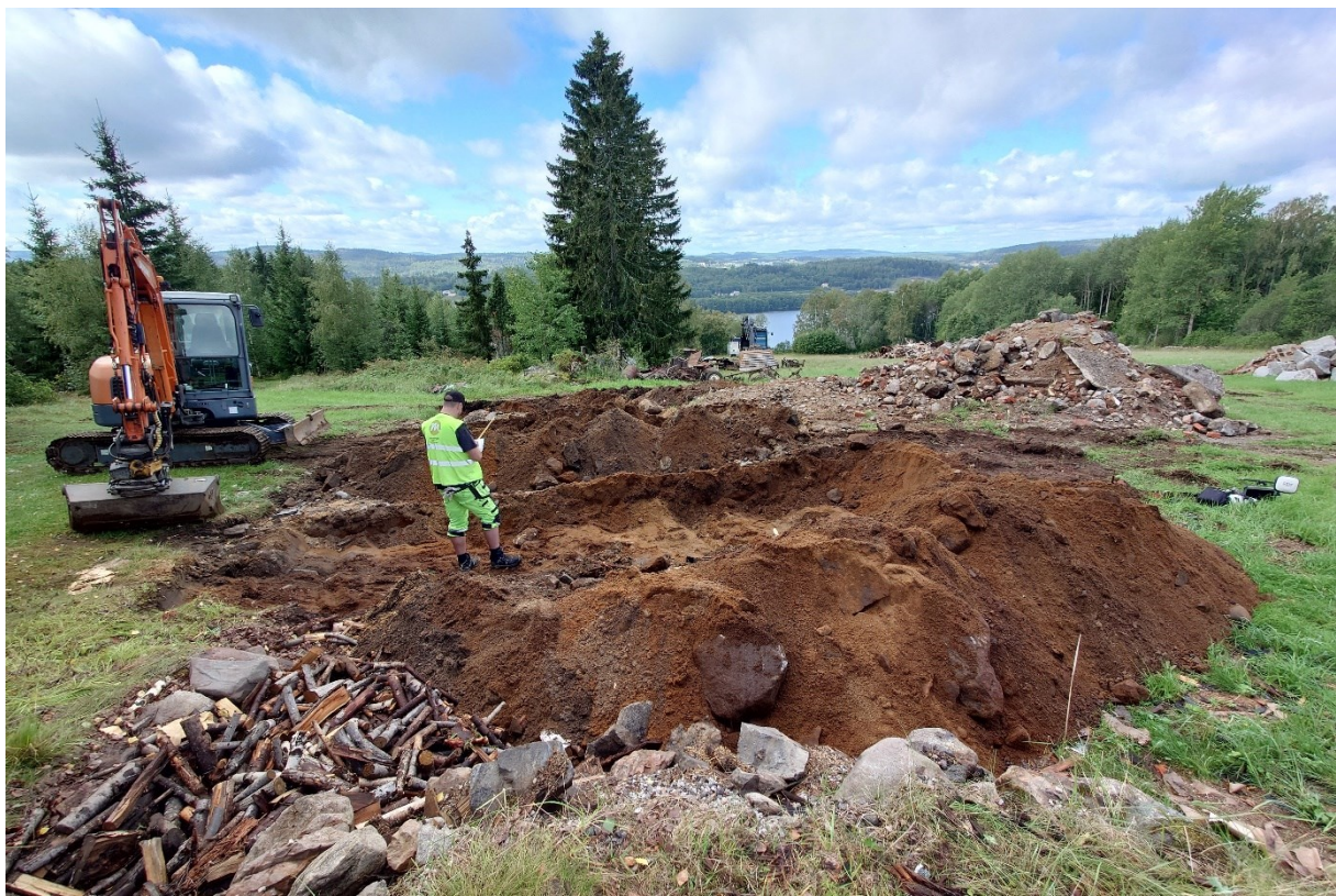
Figur 2. Schakt 1-3 på den södra ytan, arbetsbild. Foto från öster.
