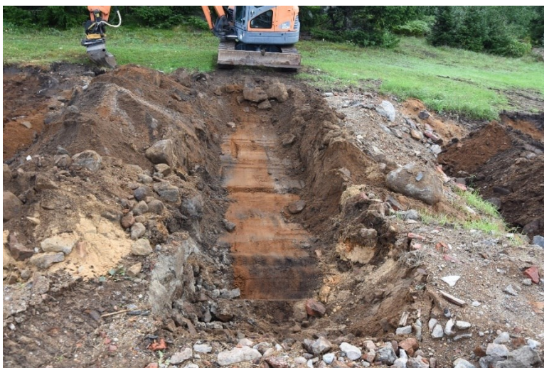
Figur 6. Schakt 2 från norr.
