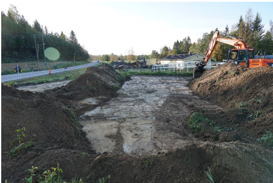
Figur 6. Schakt 3 från norr.
