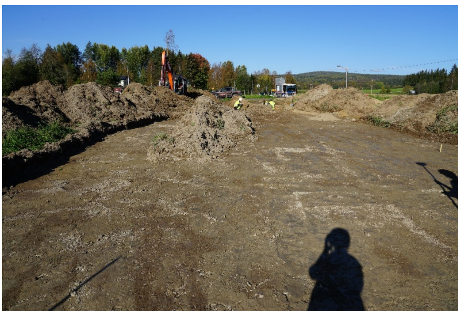
Figur 7. Del av schakt 4 från söder.
