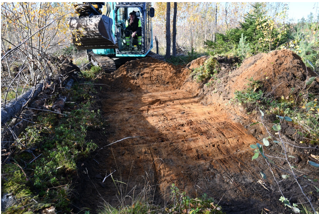
Fig. 15. Schakt 25 i områdets norra del, som var mera orörd. Foto från väster.
