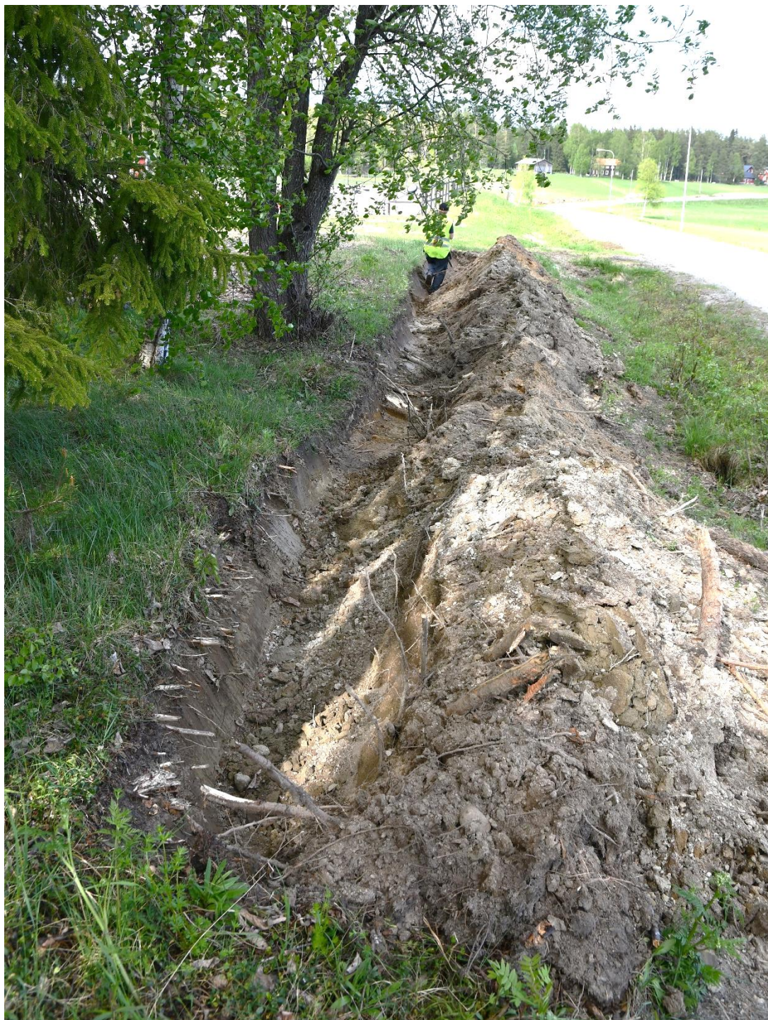
Figur 9. Schakt 8. Foto från sydväst. Bilden illustrerar svårigheterna med dokumentationen då jorden rasade ned över schakten i efterhand.
