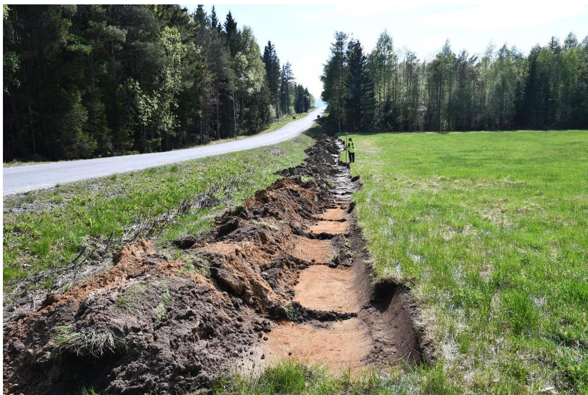
Figur 5. Schakt 1. Foto från nordost.
