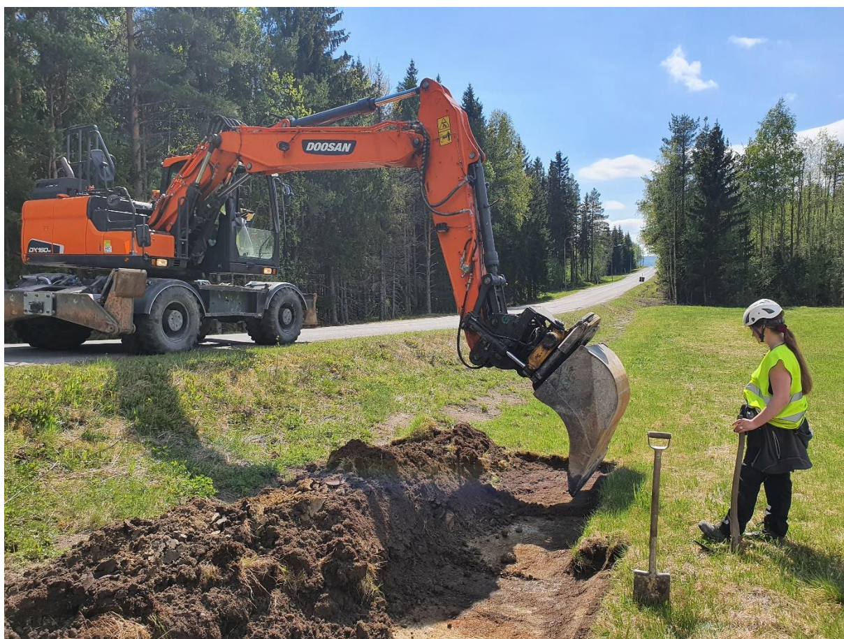
Figur 2. Schaktning på den sydvästra delen av området. Foto från norr.
