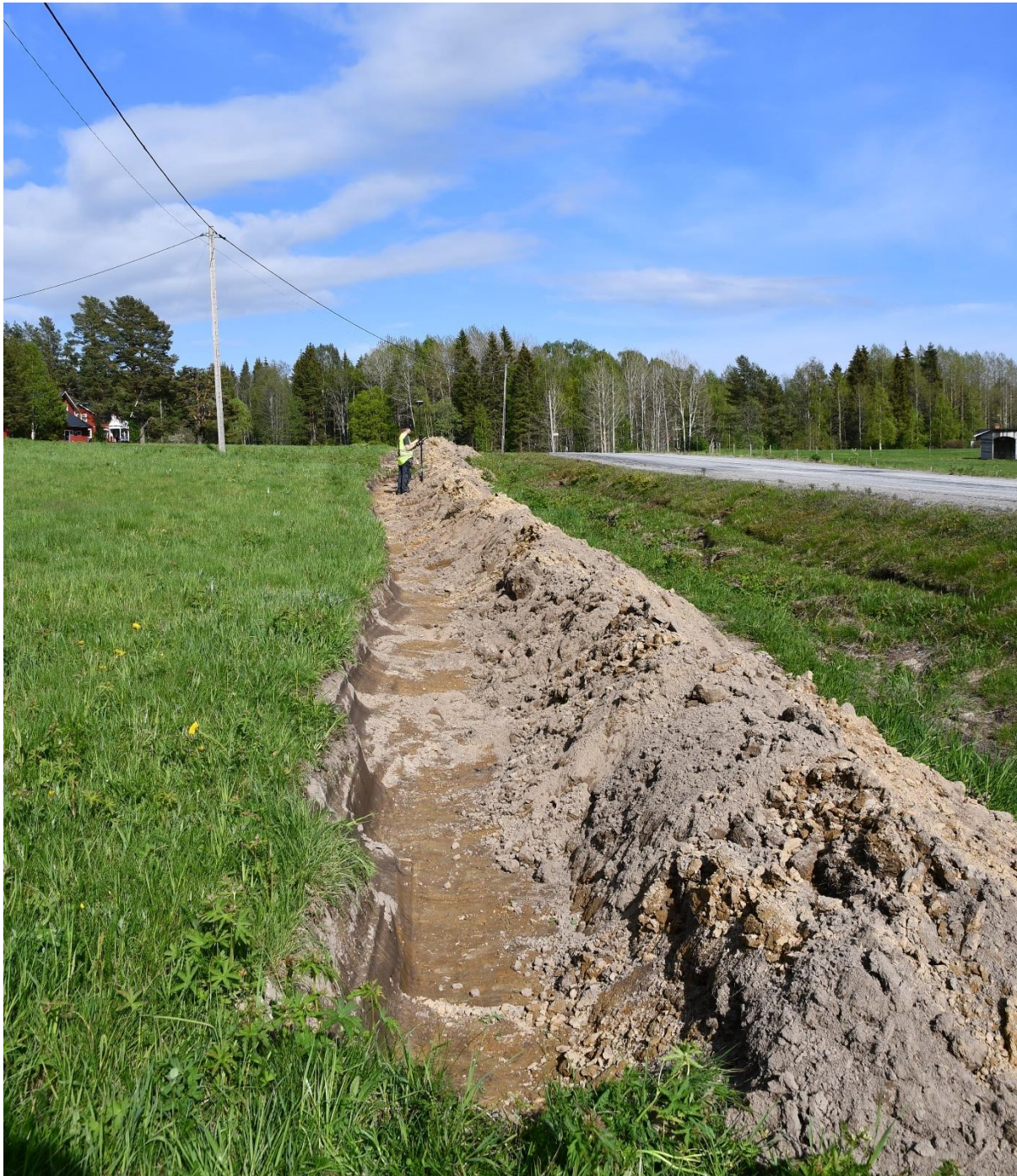
Figur 12. Schakt 12, med schakt 13 bortanför. Foto från väster.
