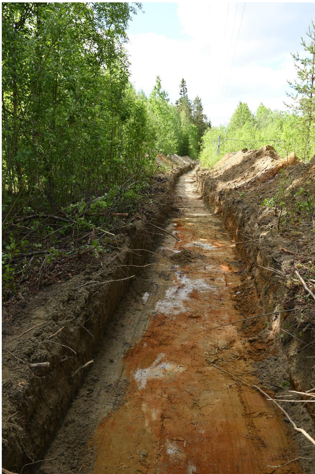
Figur 6. Norra och mellersta delen av schaktet. Foto från nordöst.
