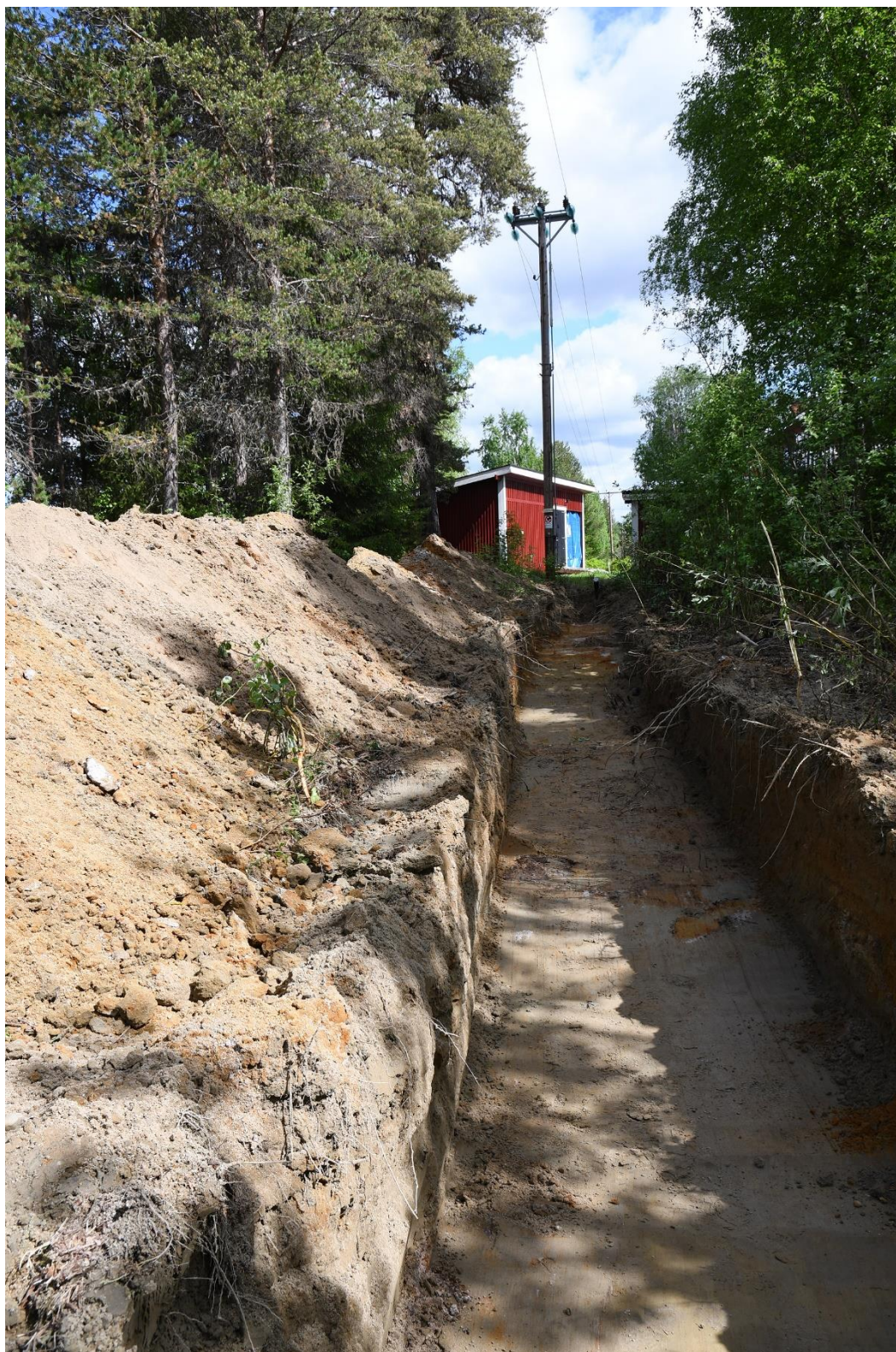
Figur 5. Norra delen av schaktet. Foto från sydväst.
