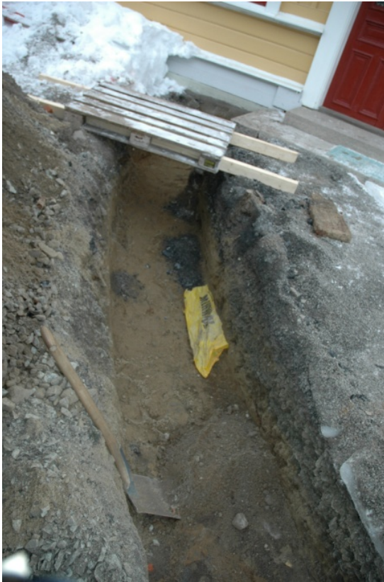
Schaktets början vid husets bro.
