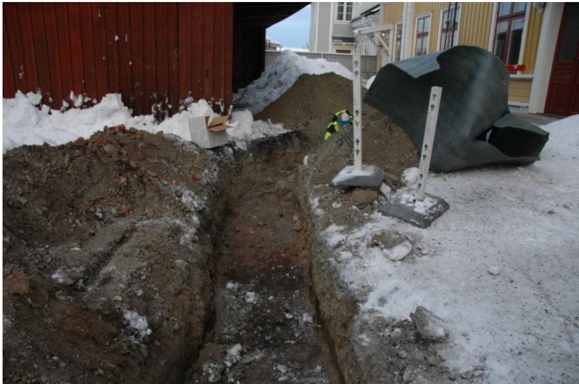
Schaktets krök efter muren.
