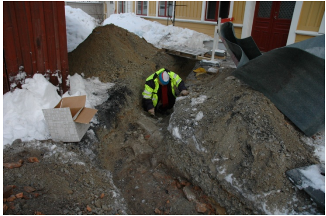
Magnus gräver runt muren.
